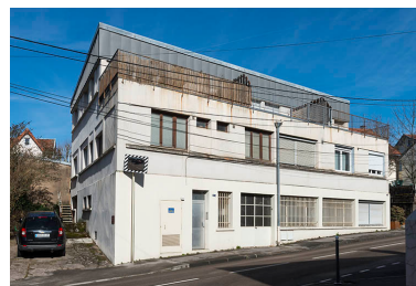
Façade antérieure. Phot. Jérôme Mongreville IVR43_20182500505NUC4A
