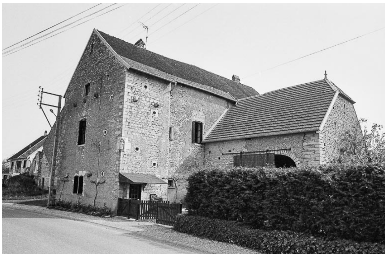
Vue d'ensemble depuis la rue.
