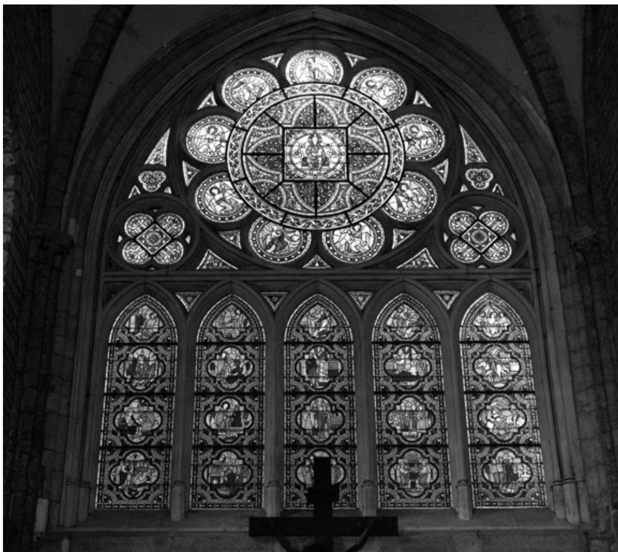
Baie 0 : vue d'ensemble.
