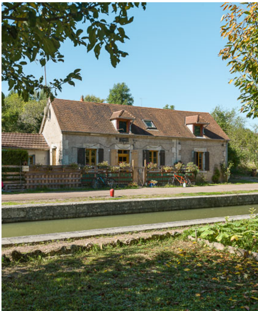
Vue de la maison éclusière.
