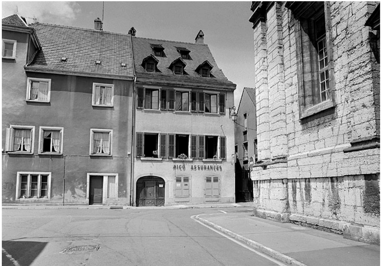
Façade principale sur la rue Saint-Martin.
