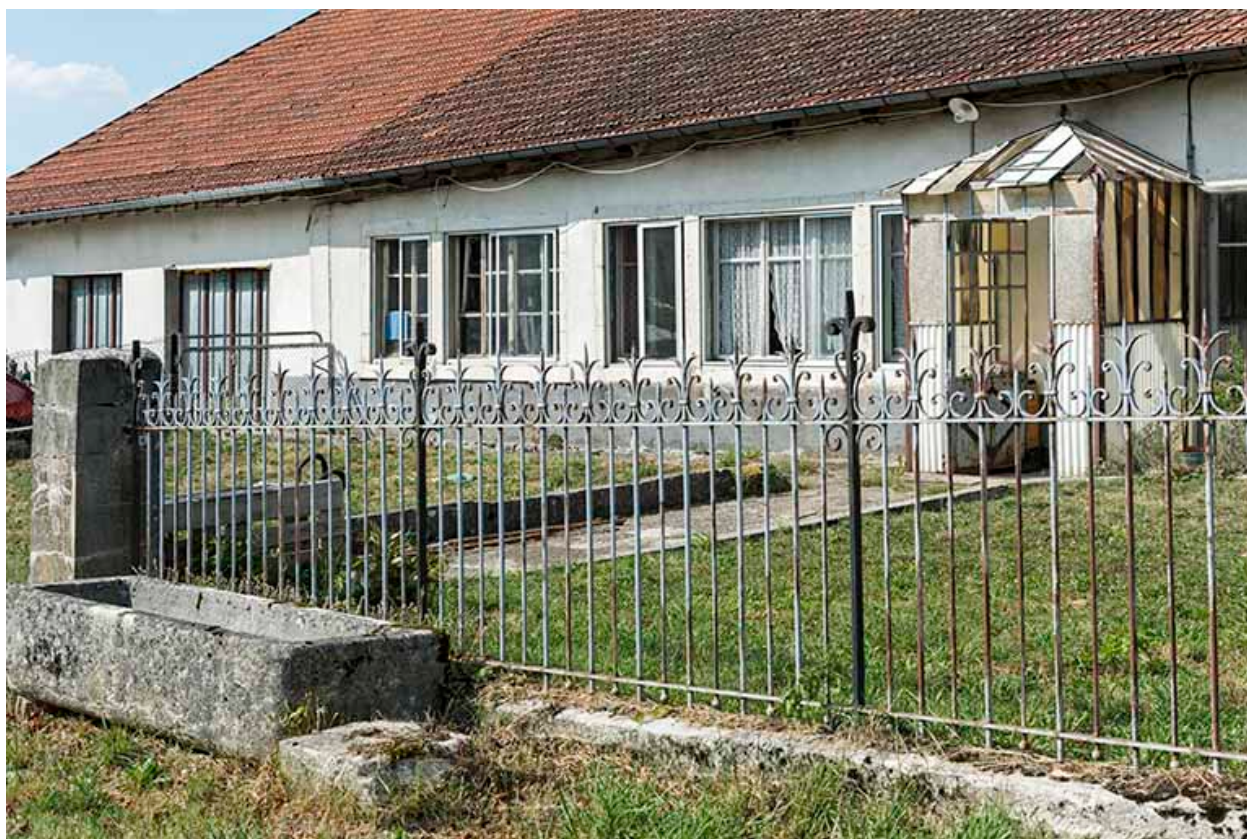
Fenêtres de l'atelier sur la façade antérieure.
