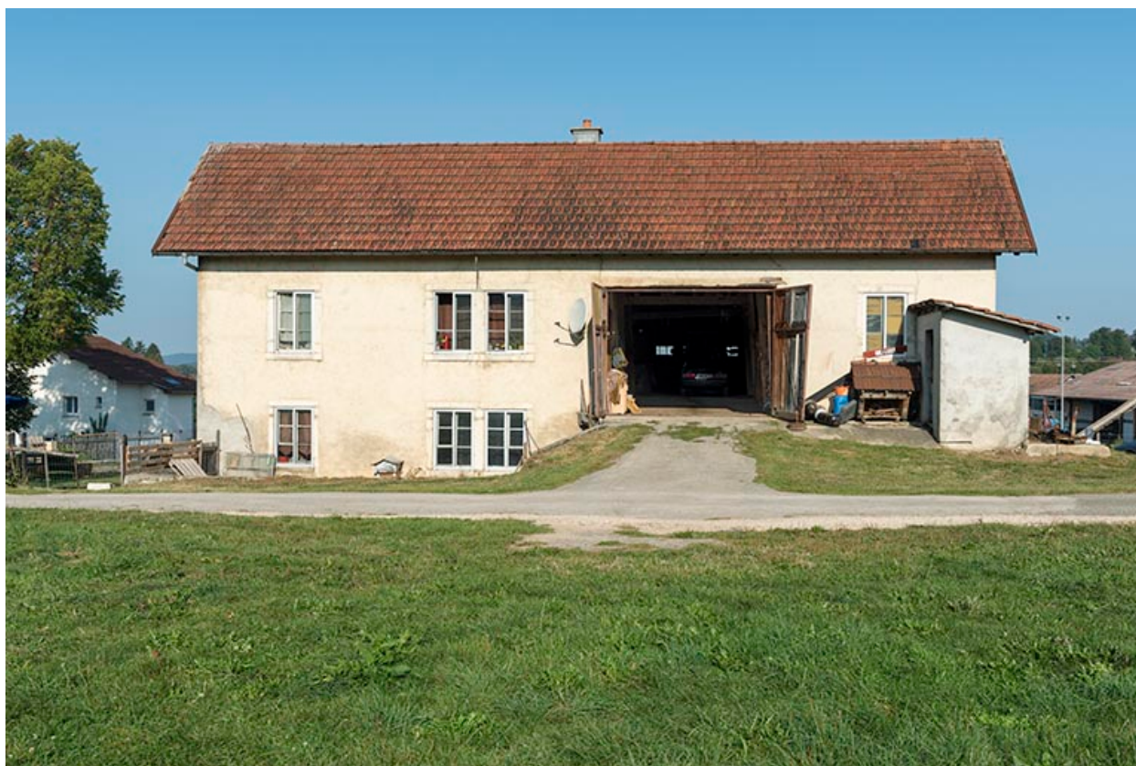
Façade latérale droite.
