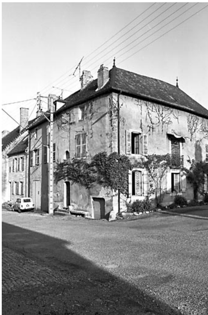
Façades antérieure et latérale droite.
