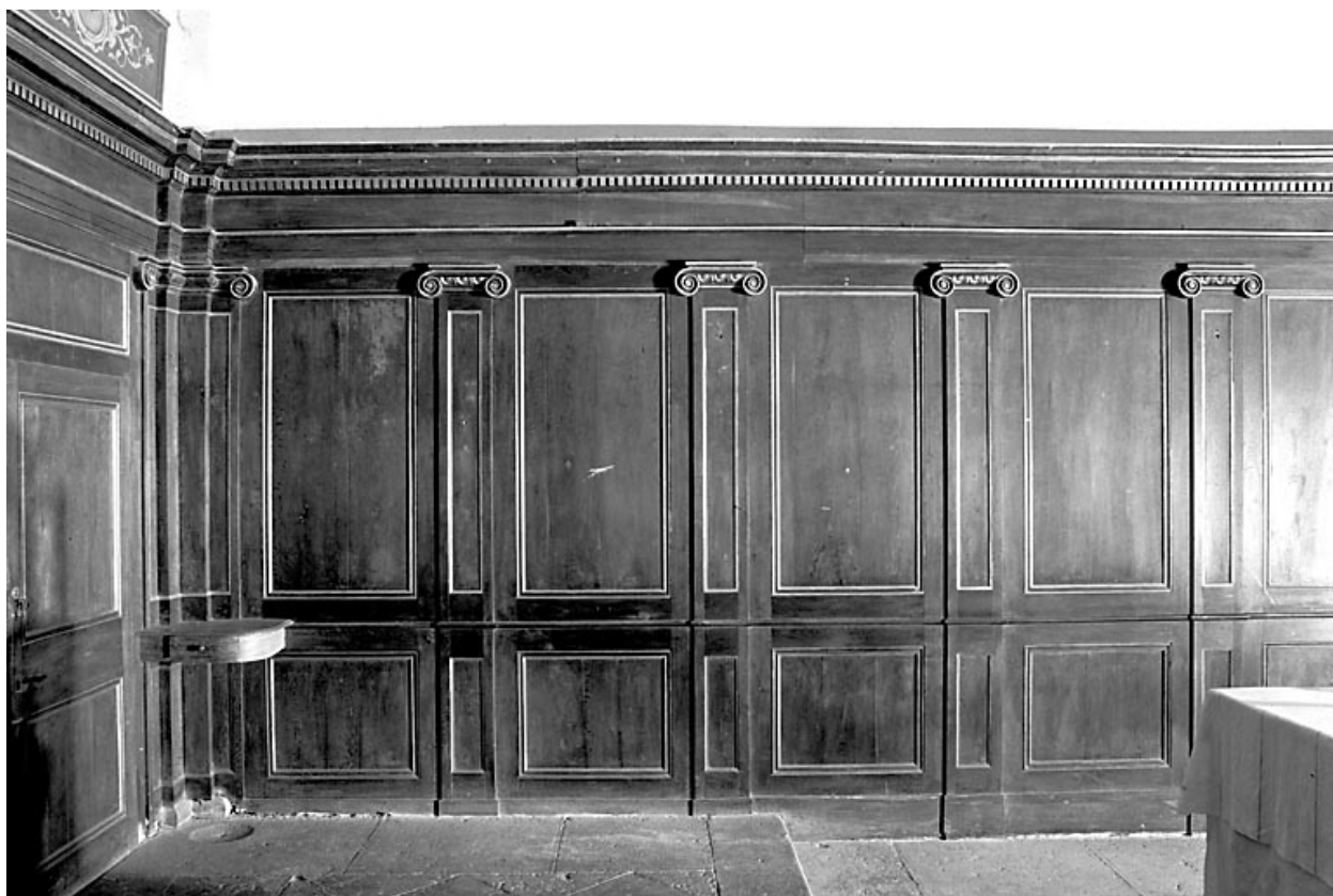
Détail des boiseries du chœur.
