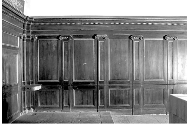
Détail des boiseries du chœur.
