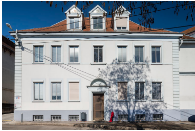
Façade antérieure des bureaux. Phot. Jérôme Mongreville IVR43_20182500543NUC4A
