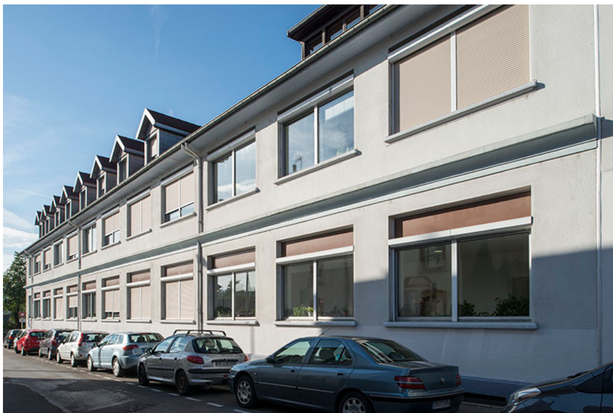
Détail de la façade.
