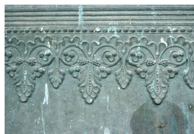
Détail de la frise. Phot. Pierre-Marie Barbe-Richaud IVR26_20162100106NUC2A
