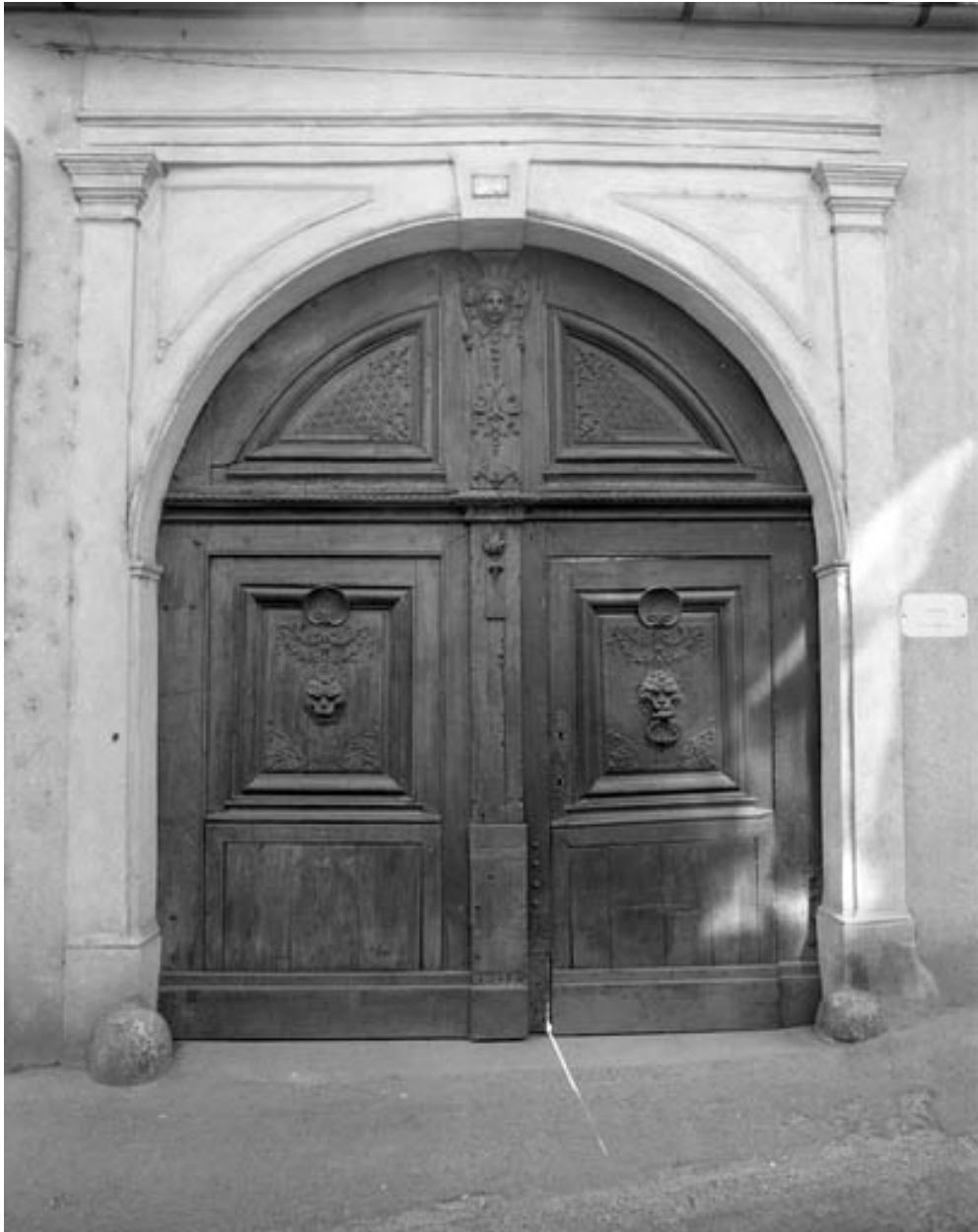
Portail d'entrée : vantaux de la porte.
