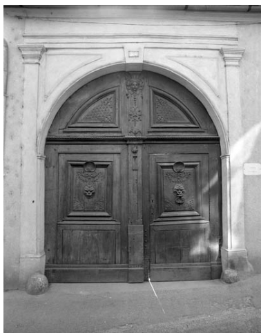
Portail d'entrée : vantaux de la porte.
