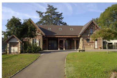
Façade nord de l'ancienne écurie (?). Phot. Jérôme Mongreville IVR43_20057000532NUCA
