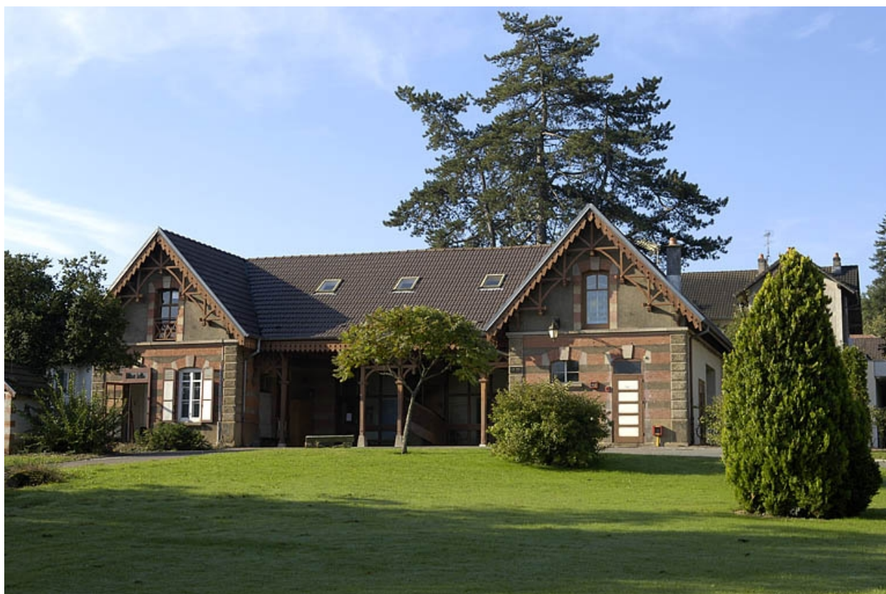
Vue d'ensemble de l'ancienne écurie (?).
