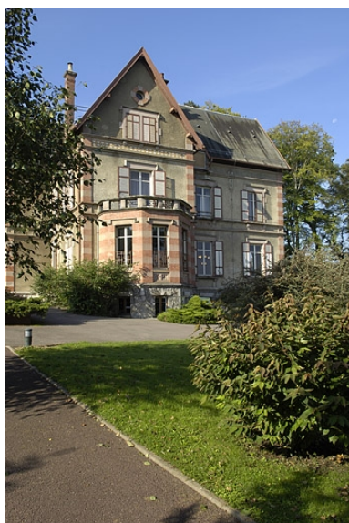
Façade nord. Phot. Jérôme Mongreville IVR43_20057000535NUCA
