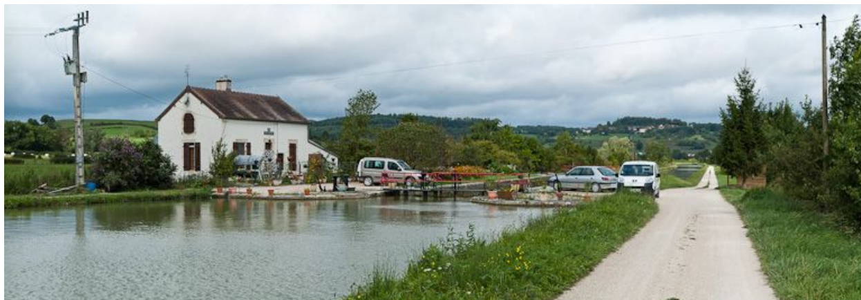
Vue du site d'écluse depuis l'amont.
