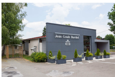
Le corps d'entrée. Phot. Yves Sancey IVR43_20132501149NUC2A
