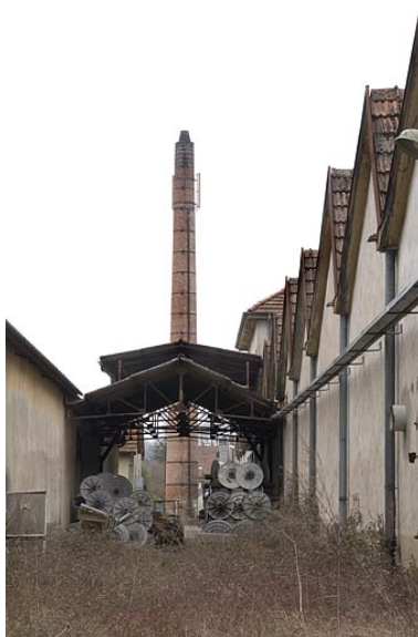
La cheminée vue depuis le nord. Phot. Jérôme Mongreville IVR43_20097000640NUC2A
