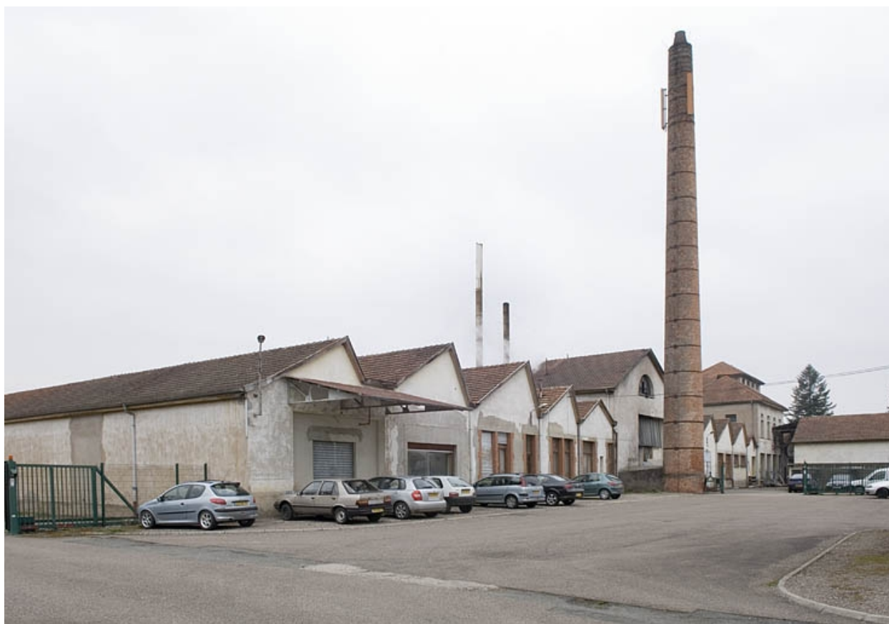
Vue de trois quarts depuis la cour.
