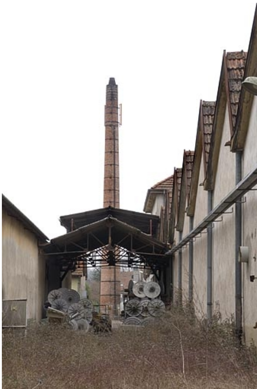
La cheminée vue depuis le nord.
