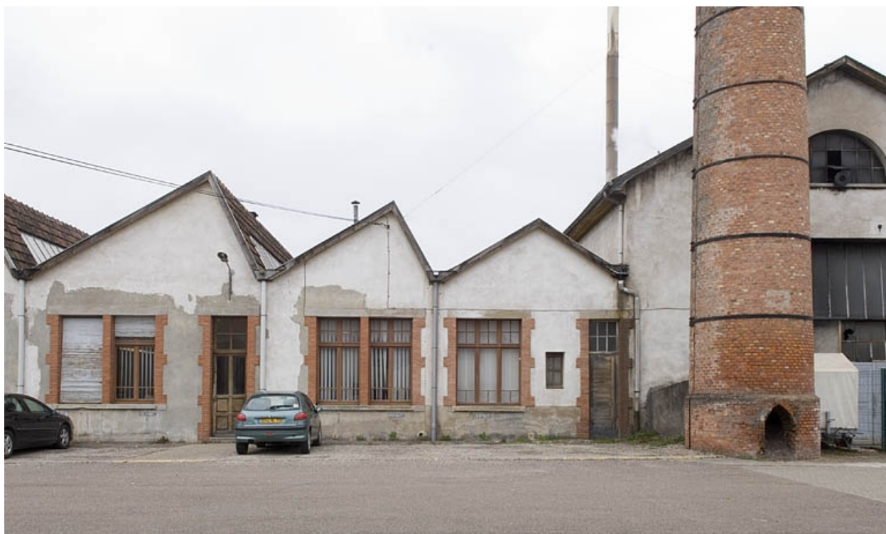
Façade est : bureaux, cheminée et chaufferie.
