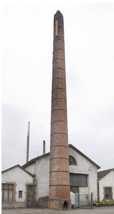
La cheminée et la chaufferie. Phot. Jérôme Mongreville IVR43_20097000637NUC2A
