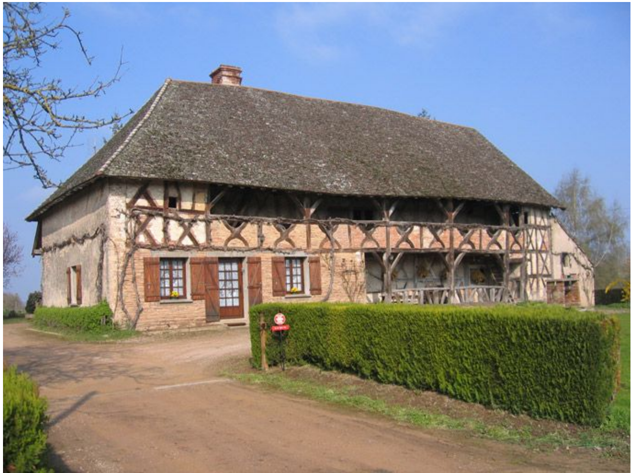
Vue d'ensemble de la façade.
