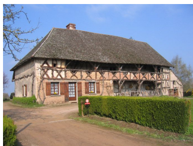
Vue d'ensemble de la façade.
