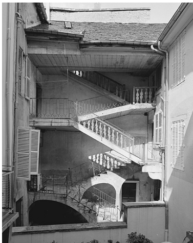
Escalier dans la cour. Phot. Yves Sancey IVR43_19833900209X
