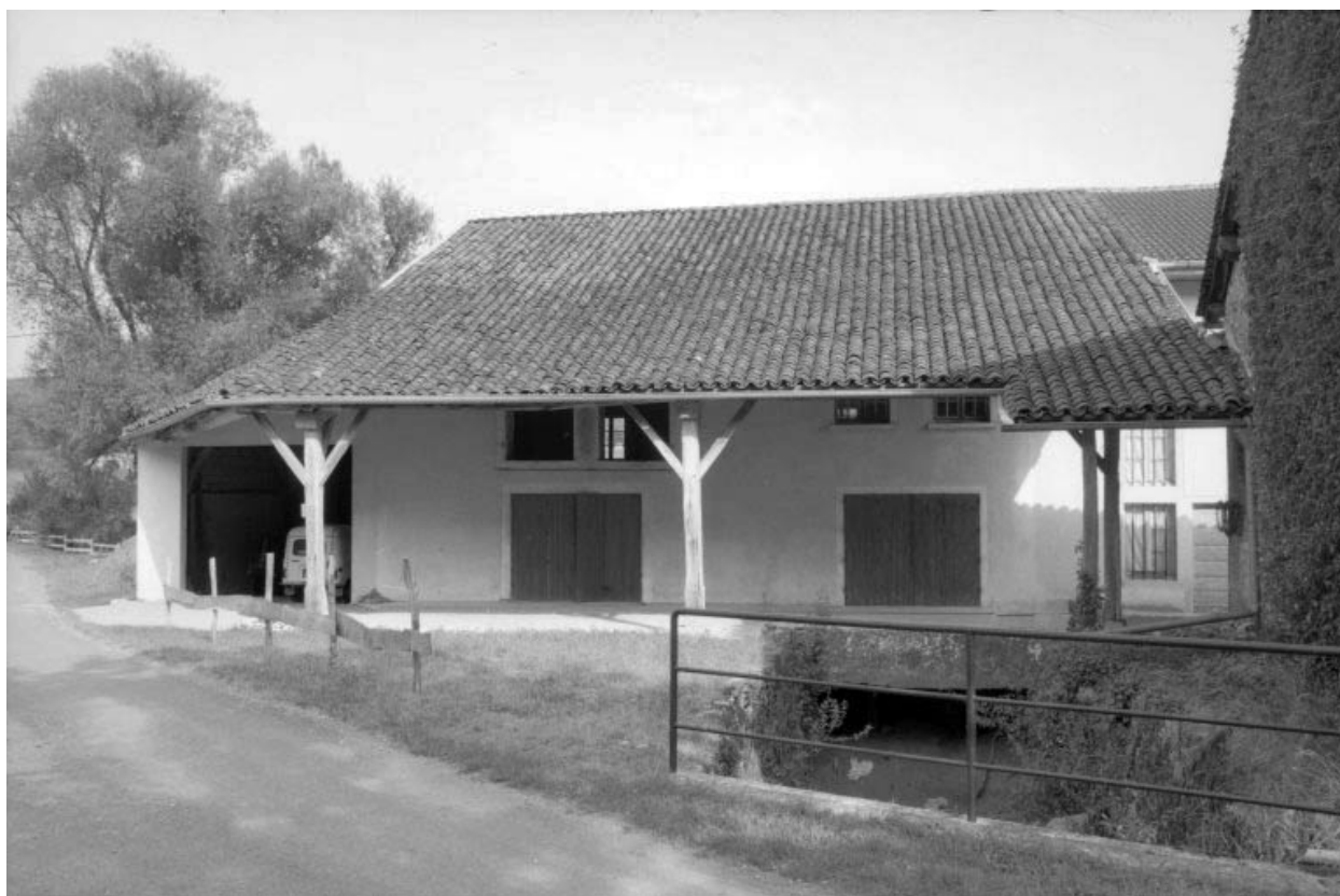
Canal d'amenée et auvent.
