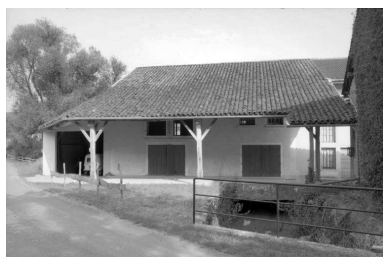
Canal d'amenée et auvent. Phot. Laurent Poupard IVR43_19923901251Z
