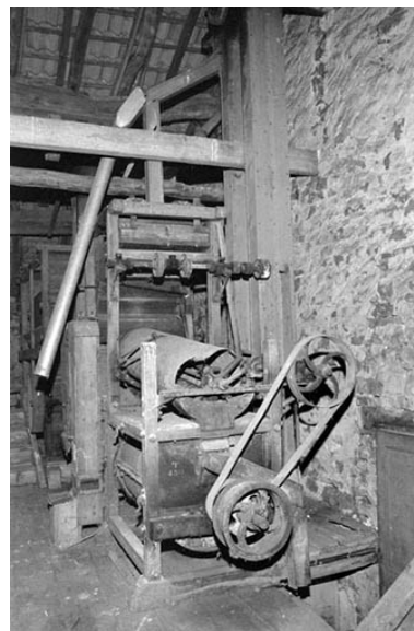
Trieur à grains (étage en surcroît). Phot. Laurent Poupard IVR43_19923901257Z
