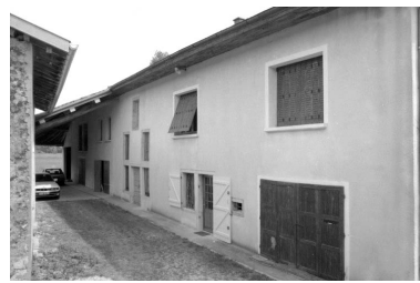
Façade antérieure. Phot. Laurent Poupard IVR43_19923901250Z
