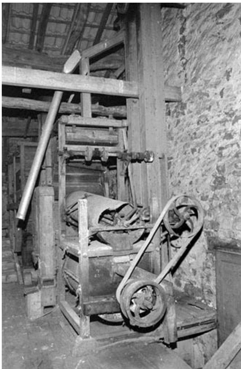
Trieur à grains (étage en surcroît).
