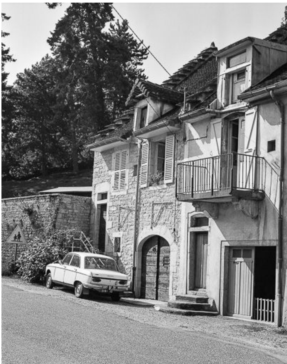
Maison de vigneron située 4 rue de la Liberté.
