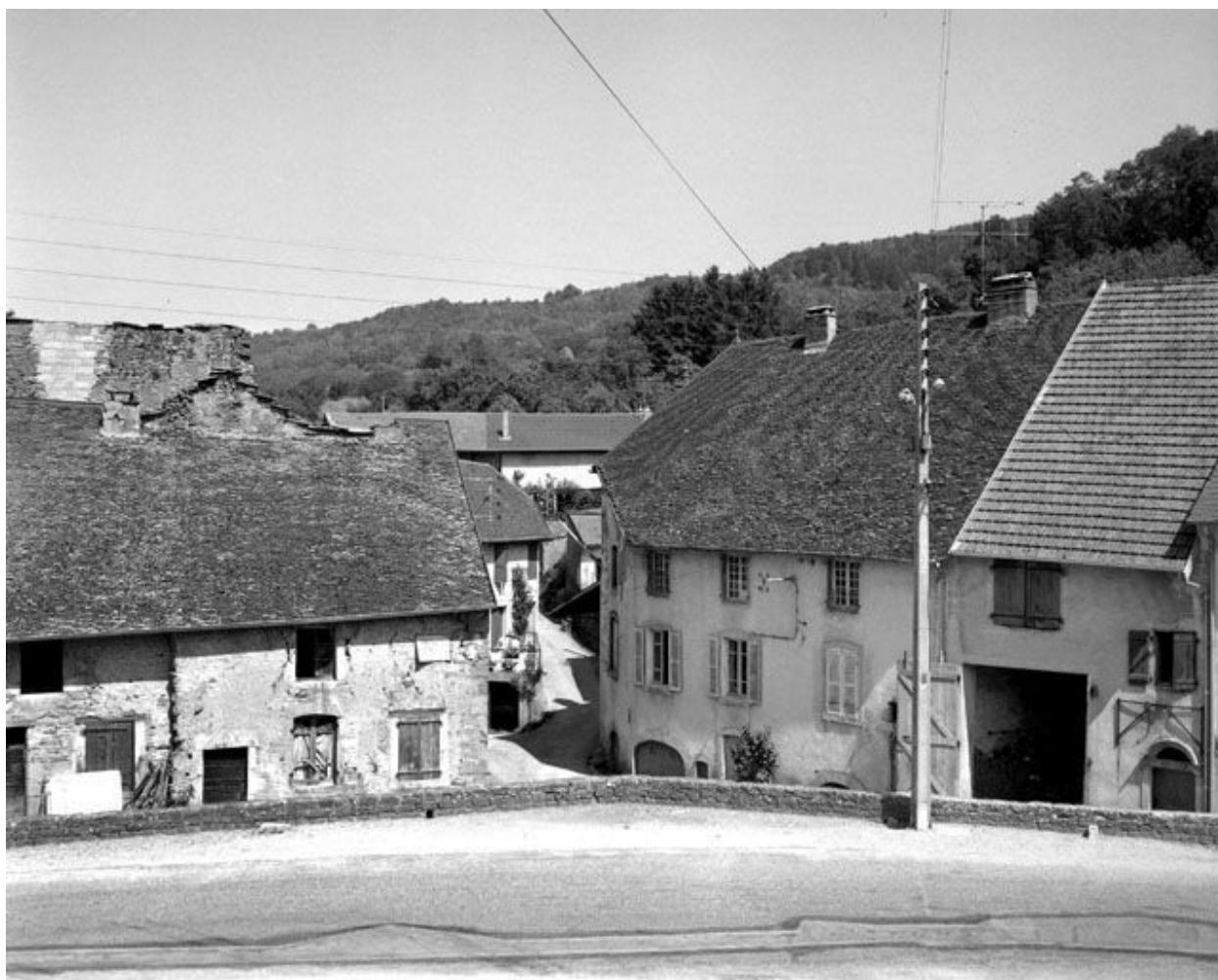
Maison de vigneron située rue du Château.
