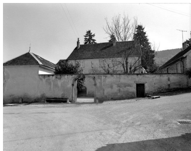
Maison de vigneron située rue Lacuzon. Phot. Yves Sancey IVR43_19843900345X
