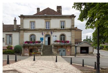
Vue générale. Phot. Sonia Dourlot IVR43_20157000518NUC2A
