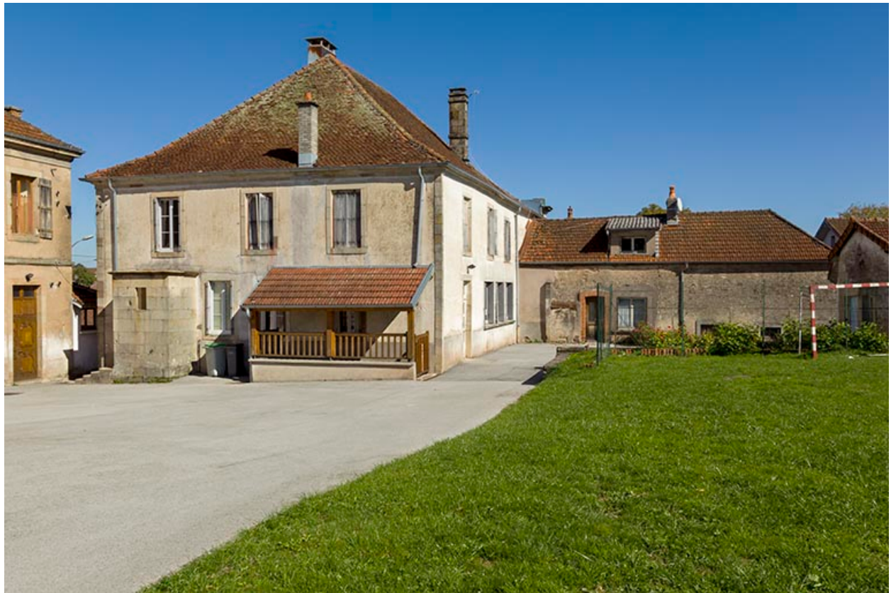
Façade postérieure de la mairie.
