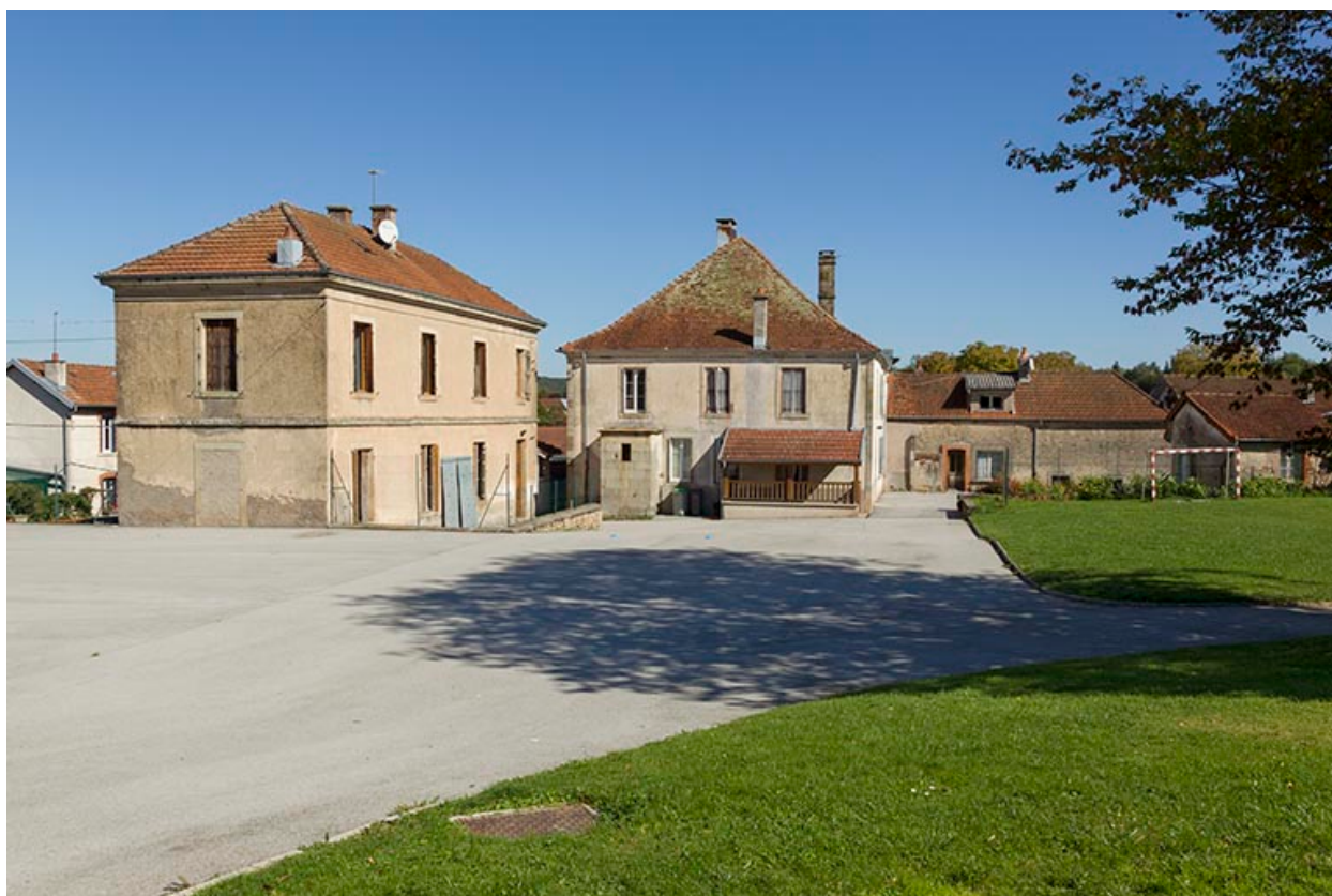
Façades sud et est de l'école.
