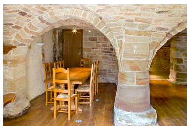
La cave voûtée de la mairie. Phot. Sonia Dourlot IVR43_20157000521NUC2A
