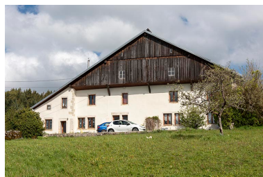
Façade antérieure. Phot. Sonia Dourlot IVR43_20192500390NUC4A
