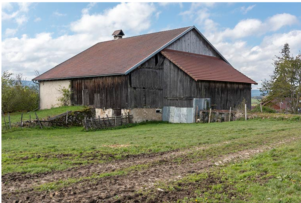
Façades postérieure et latérale droite.
