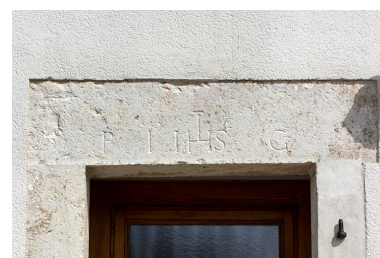
Linteau avec initiales et IHS. Phot. Sonia Dourlot IVR43_20192500393NUC4A
