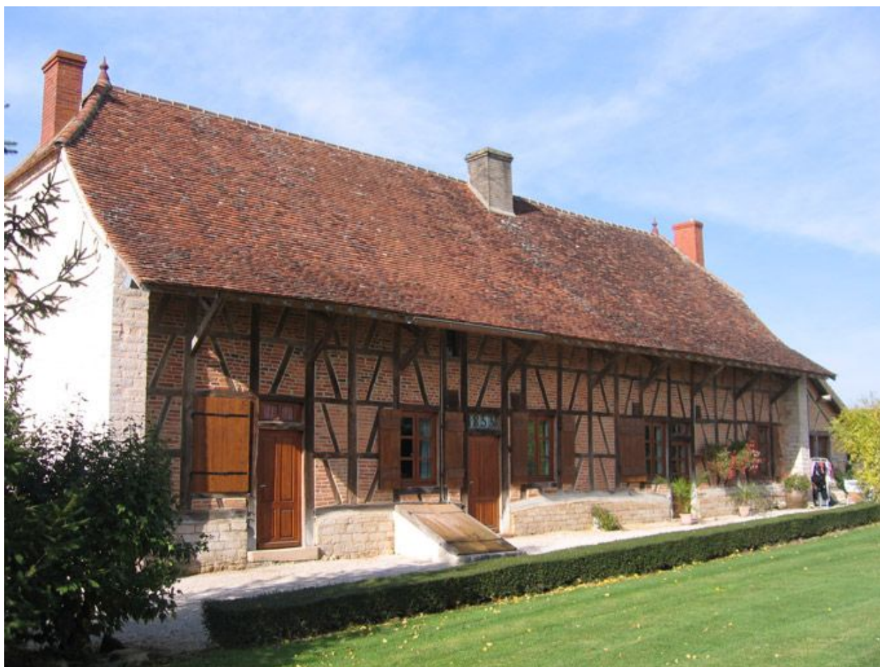
Vue d'ensemble de la façade de l'habitation.
