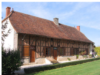
Vue d'ensemble de la façade de l'habitation.
