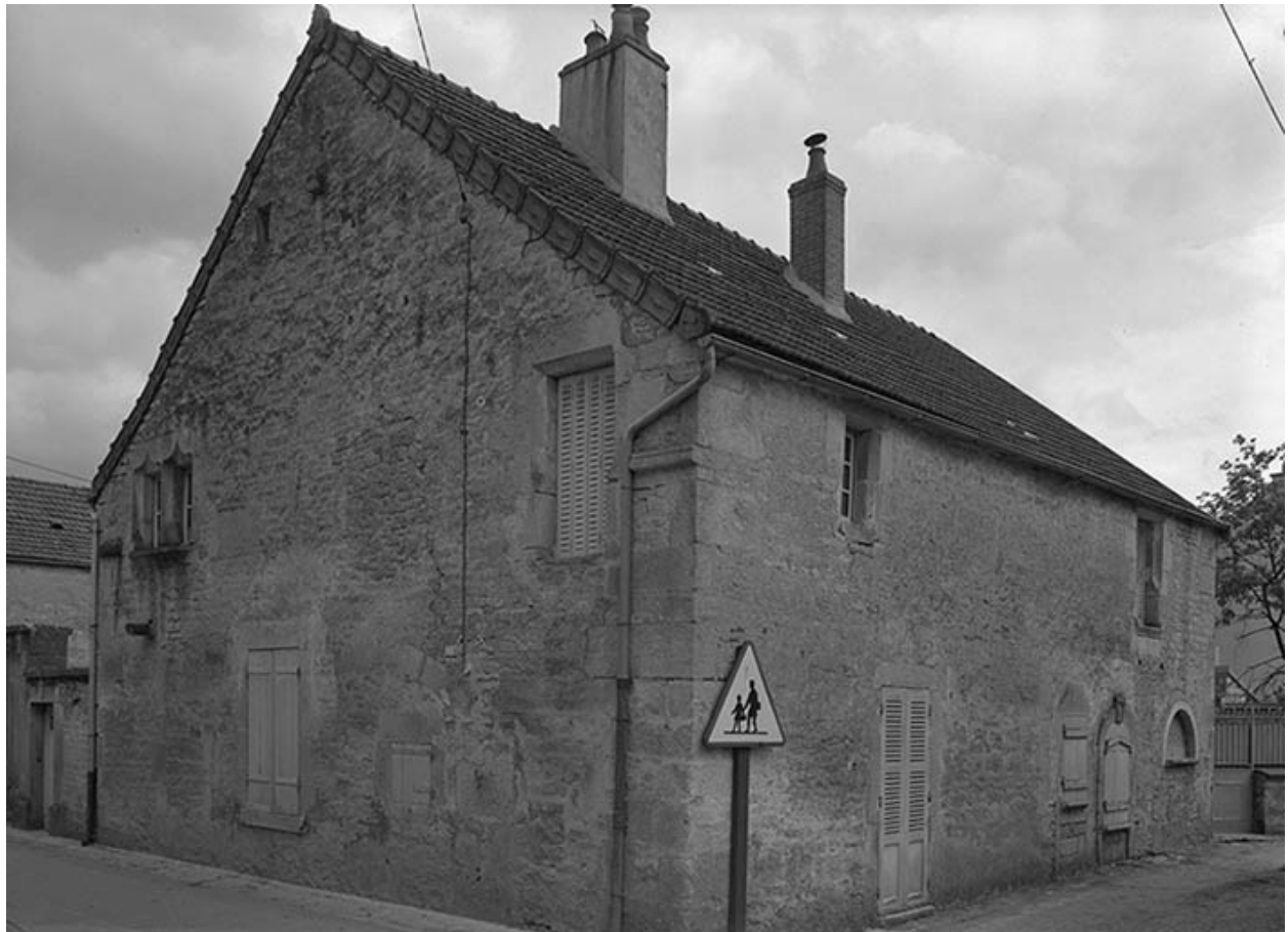
Mur-pignon et façade latérale.
