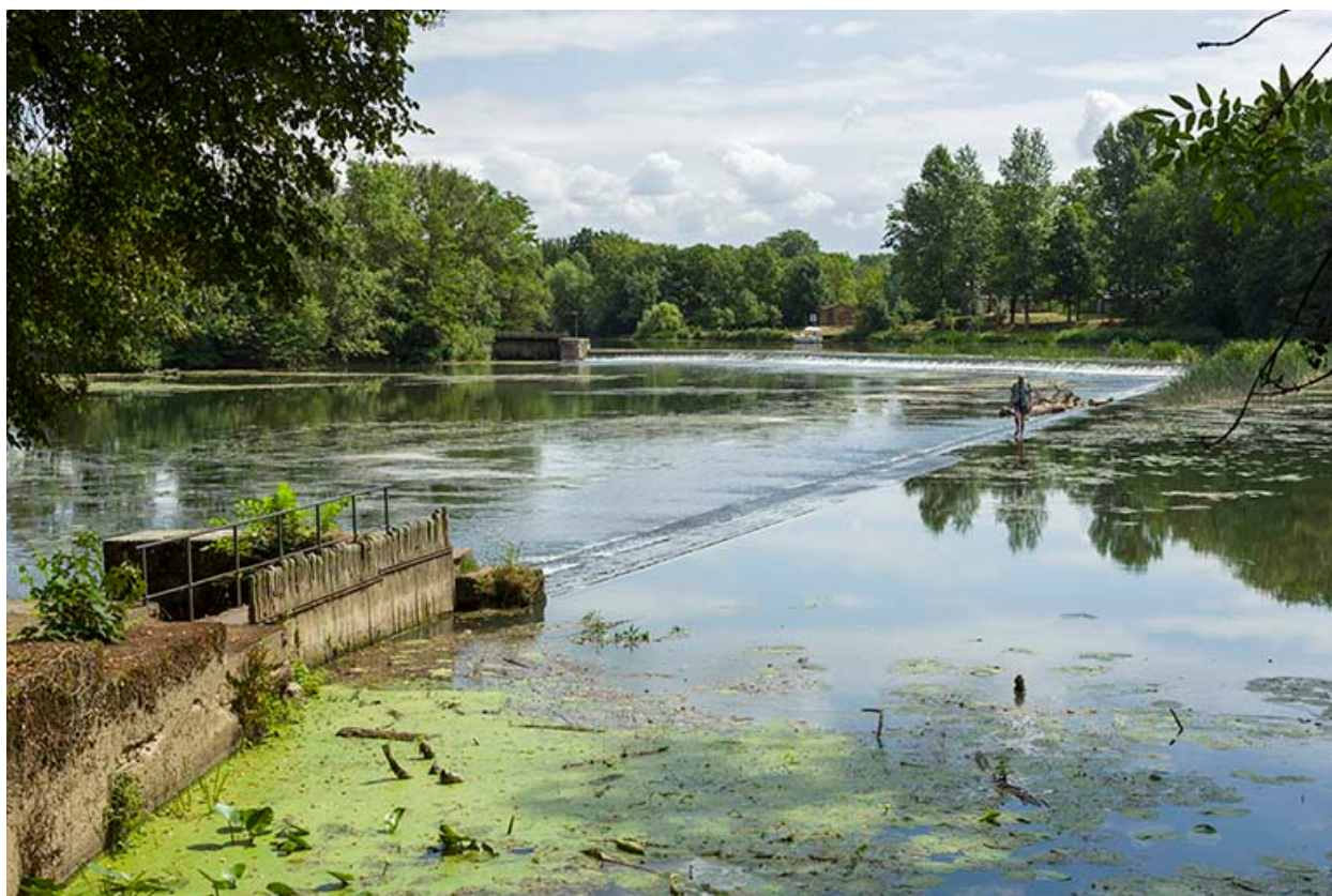
Ancien barrage usinier et la Saône.
