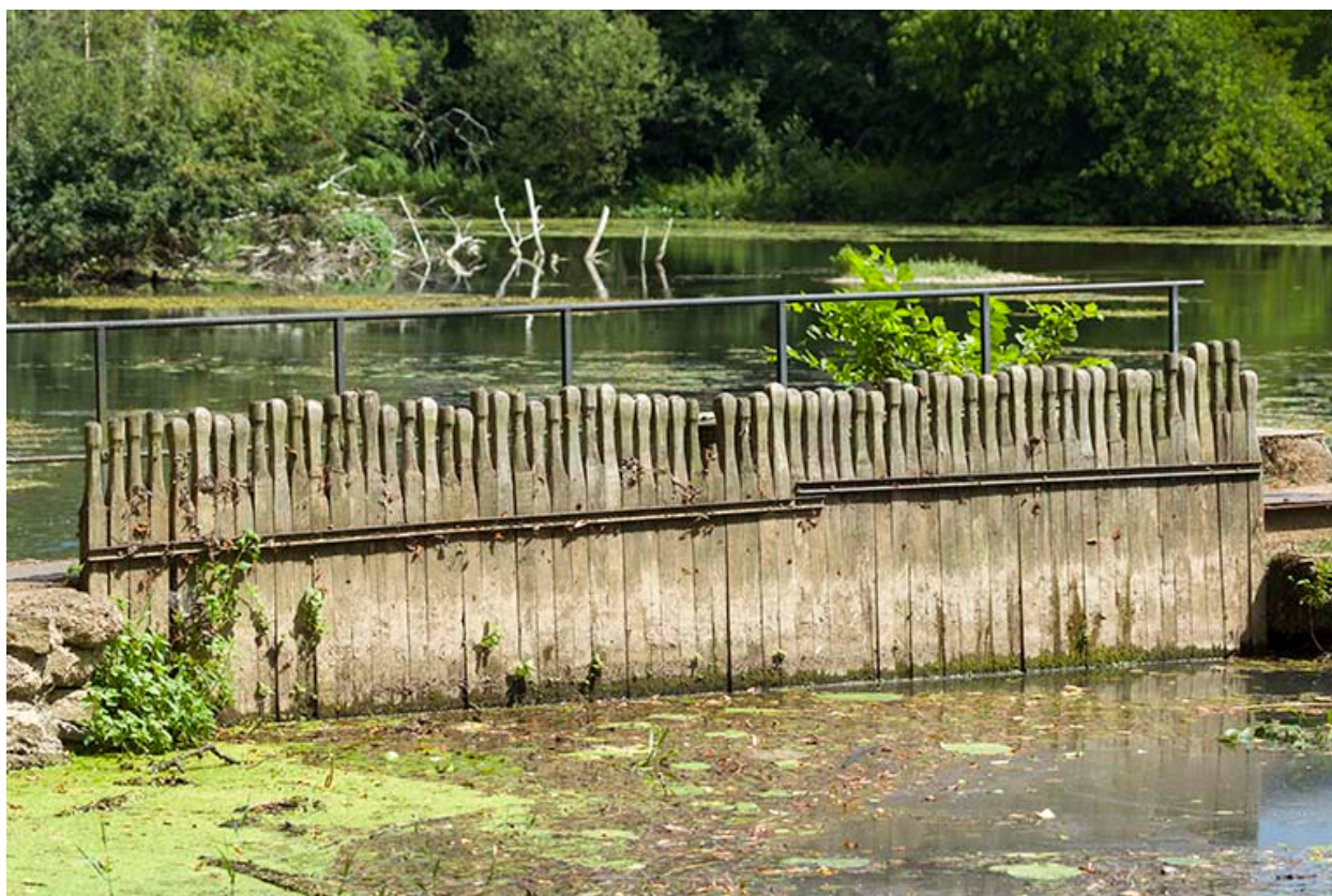
Aiguilles fermant l'ancien pertuis de navigation.
