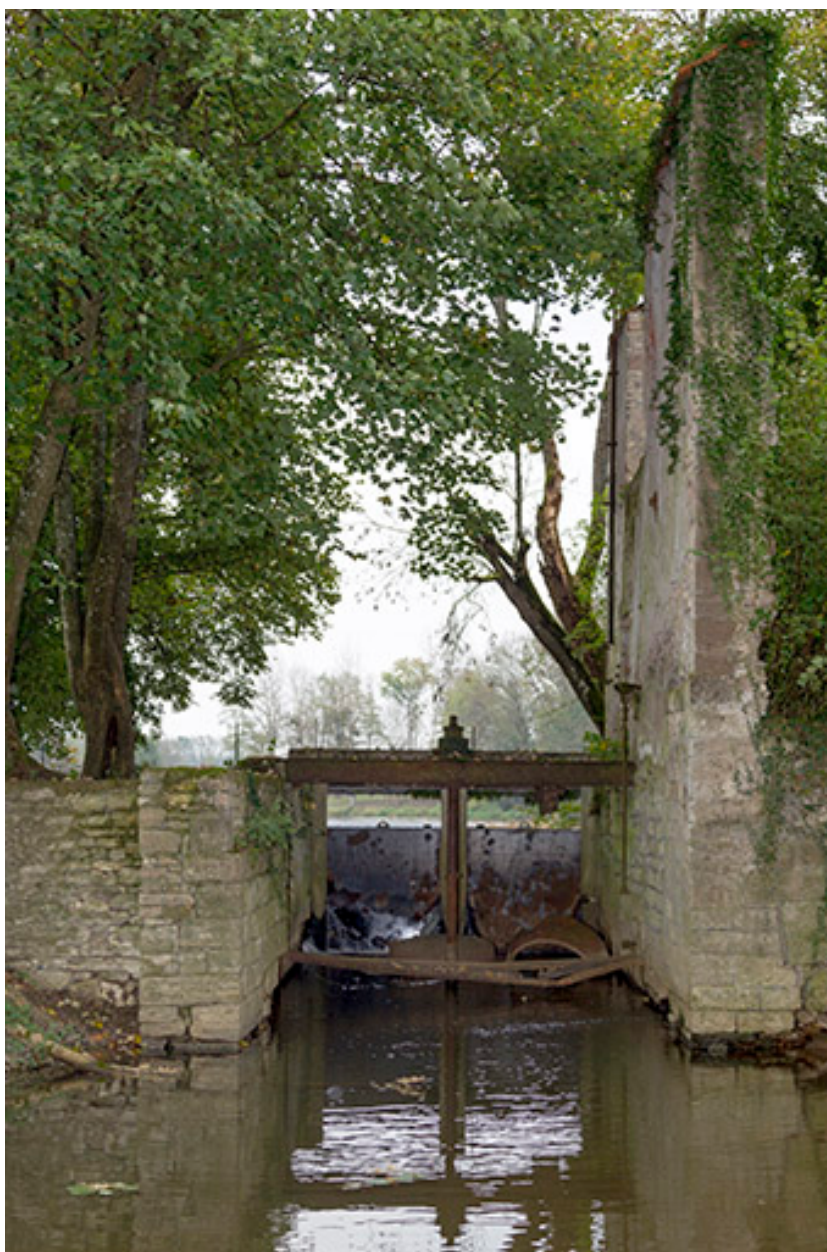
L'ancien canal de dérivation du moulin.
