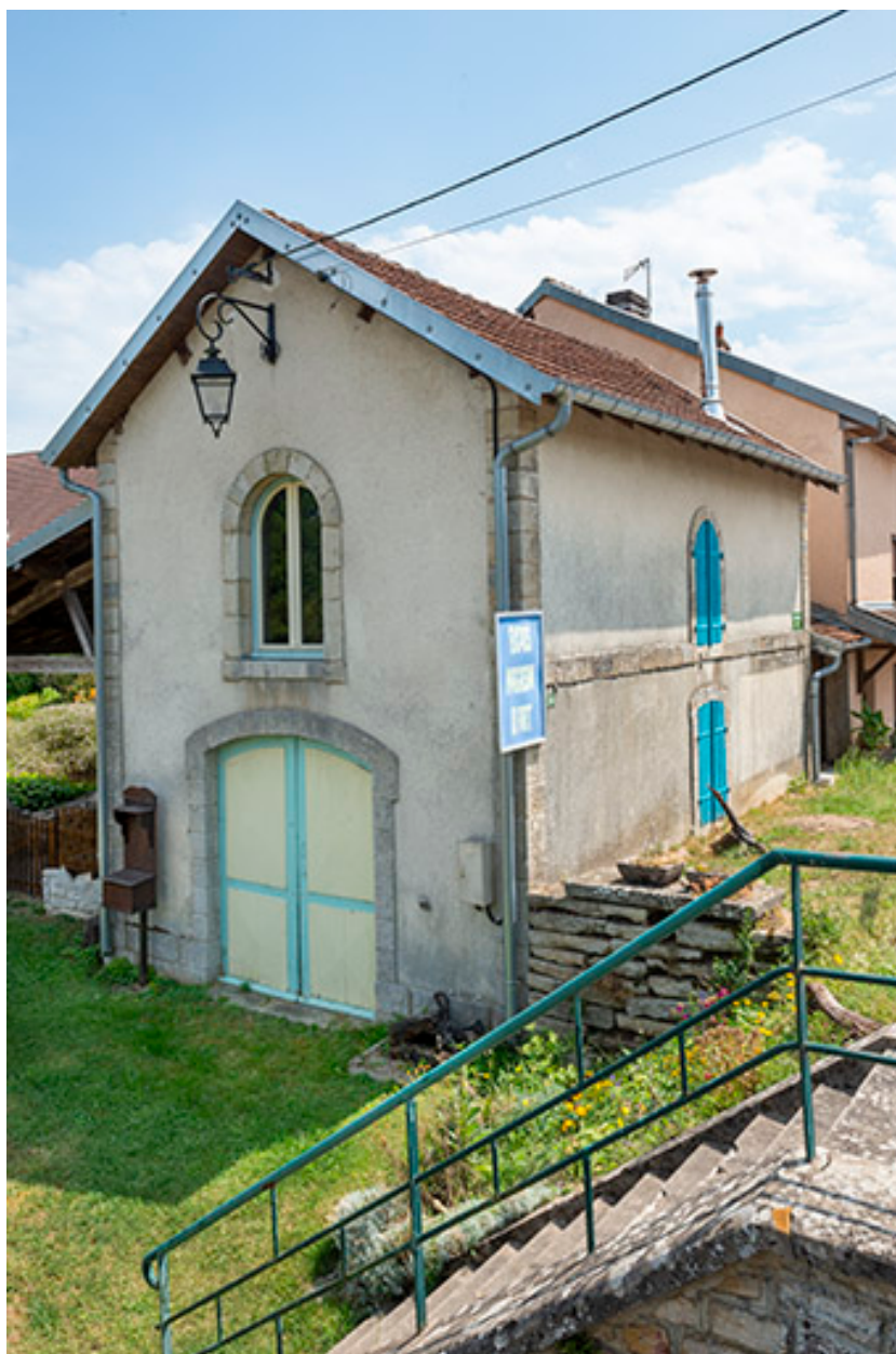
Magasin servant à la maintenance du pont-tournant.
