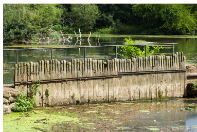
Aiguilles fermant l'ancien pertuis de navigation. Phot. Sonia Dourlot IVR43_20167001832NUC2A
