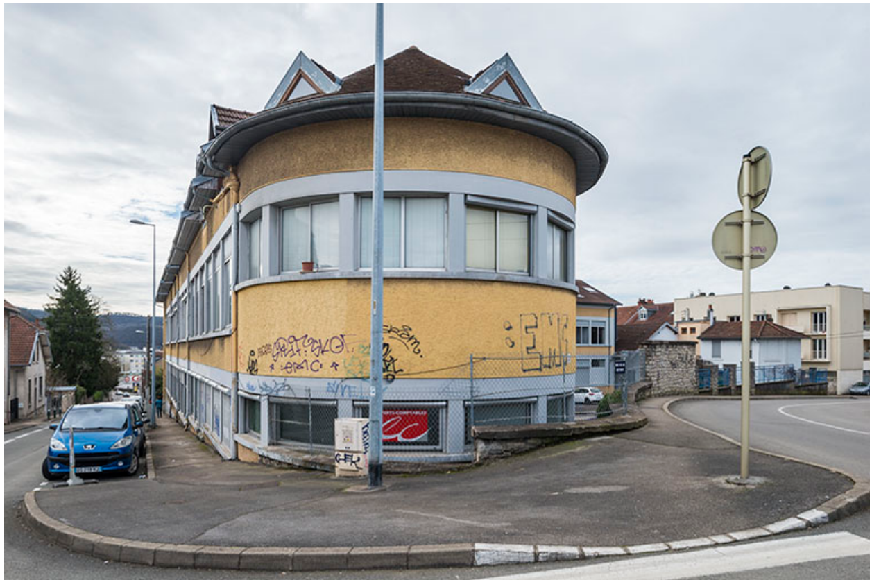
Vue depuis le nord.
