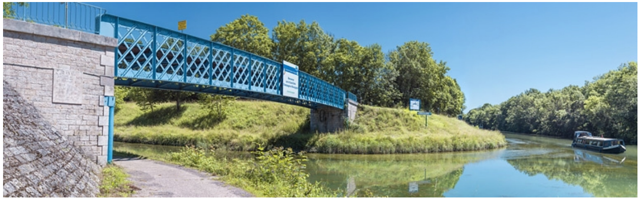
Vue d'ensemble. A droite, la dérivation d'Heuilley.
