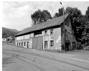
Bâtiment d'eau depuis le sud. Phot. Yves Sancey IVR43_19999000170X
