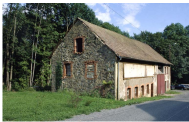
Bâtiment d'eau (ancien moulin). Phot. Yves Sancey IVR43_19999000169ZA
