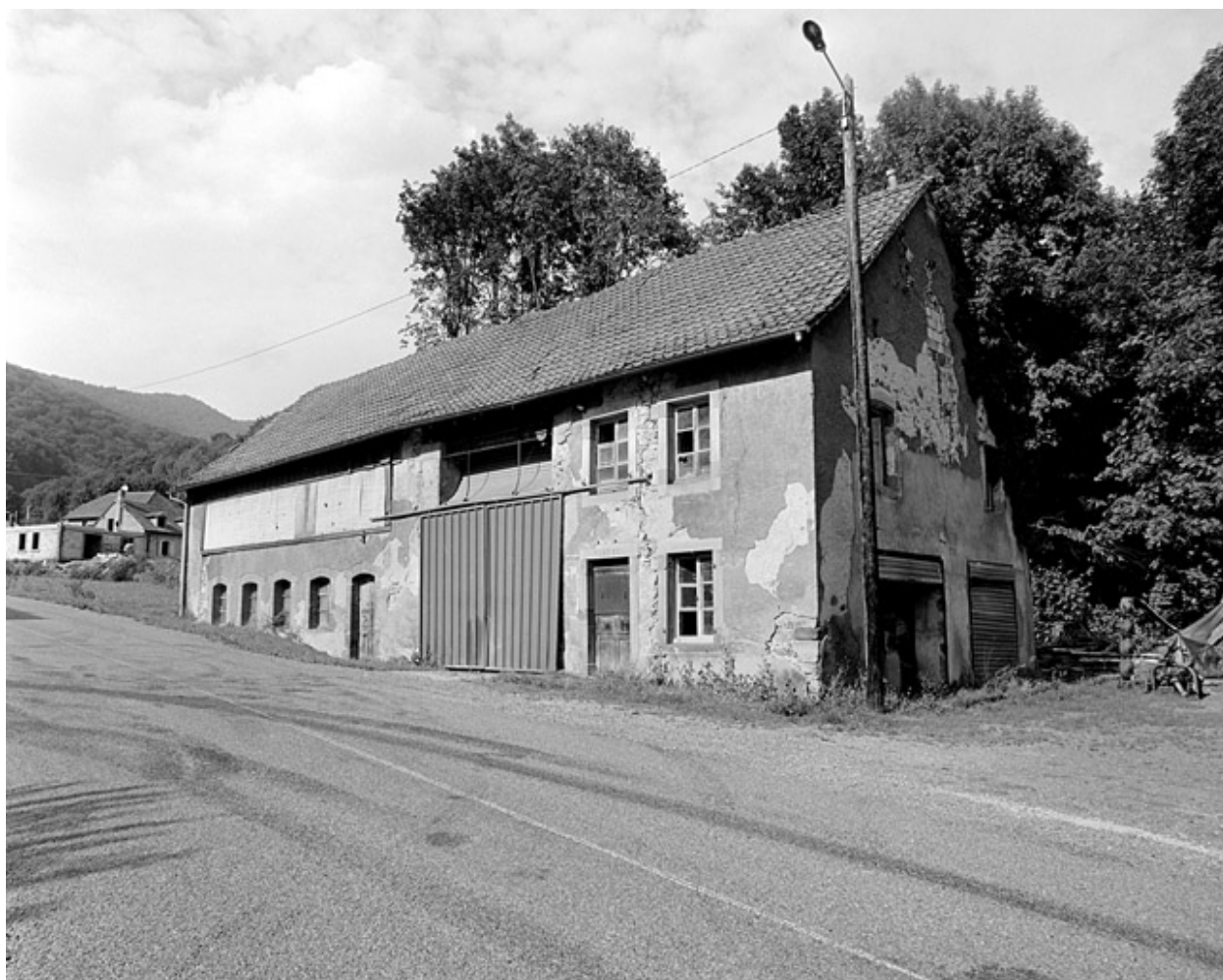
Bâtiment d'eau depuis le sud.
