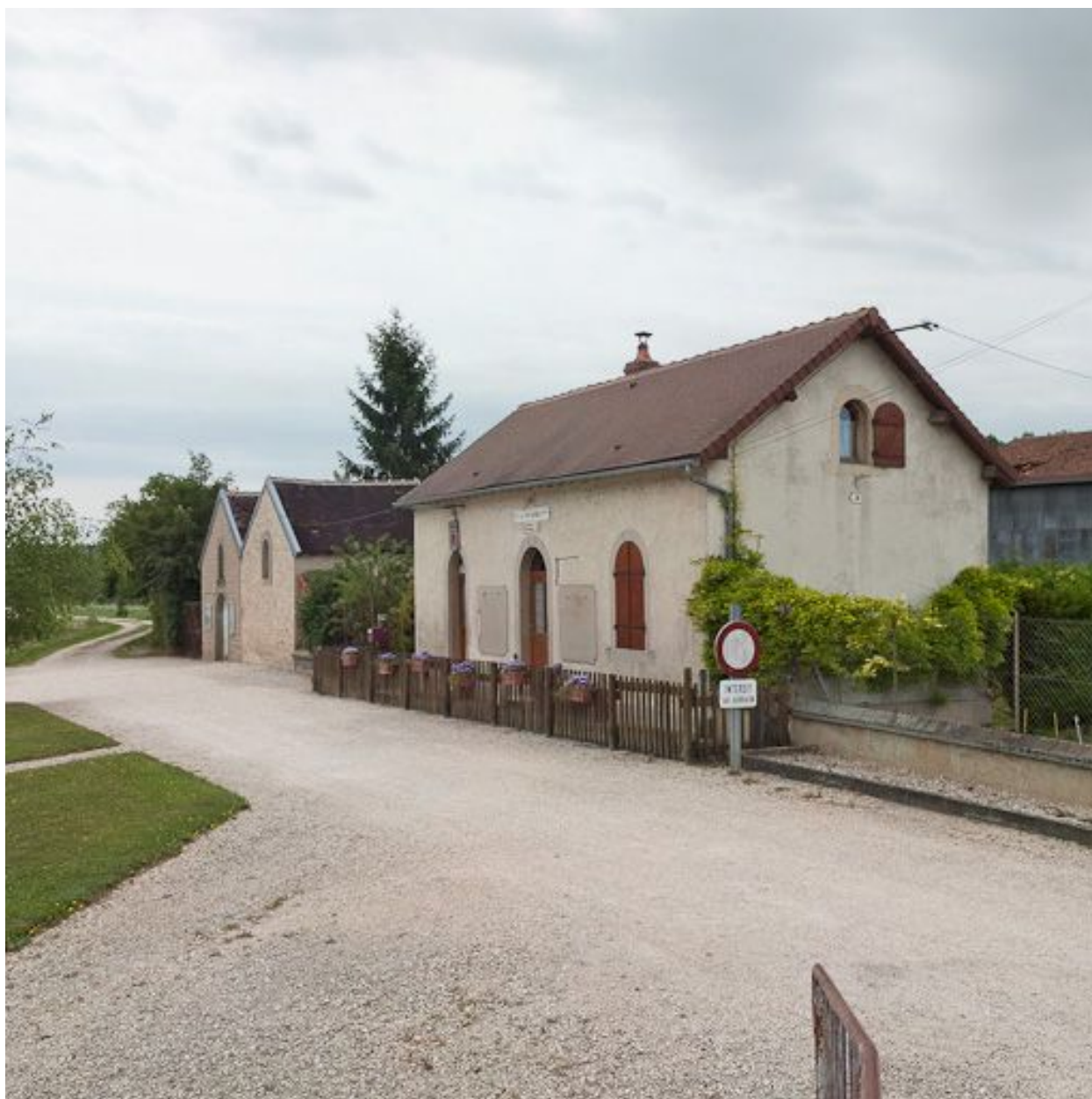
Vue de la maison éclusière.
