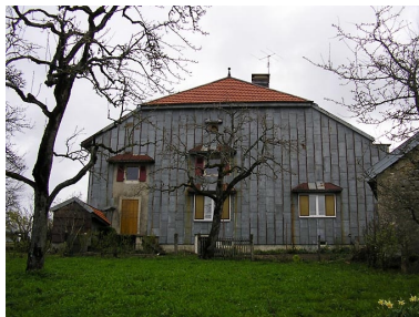
Vue générale du pignon sud-ouest.
