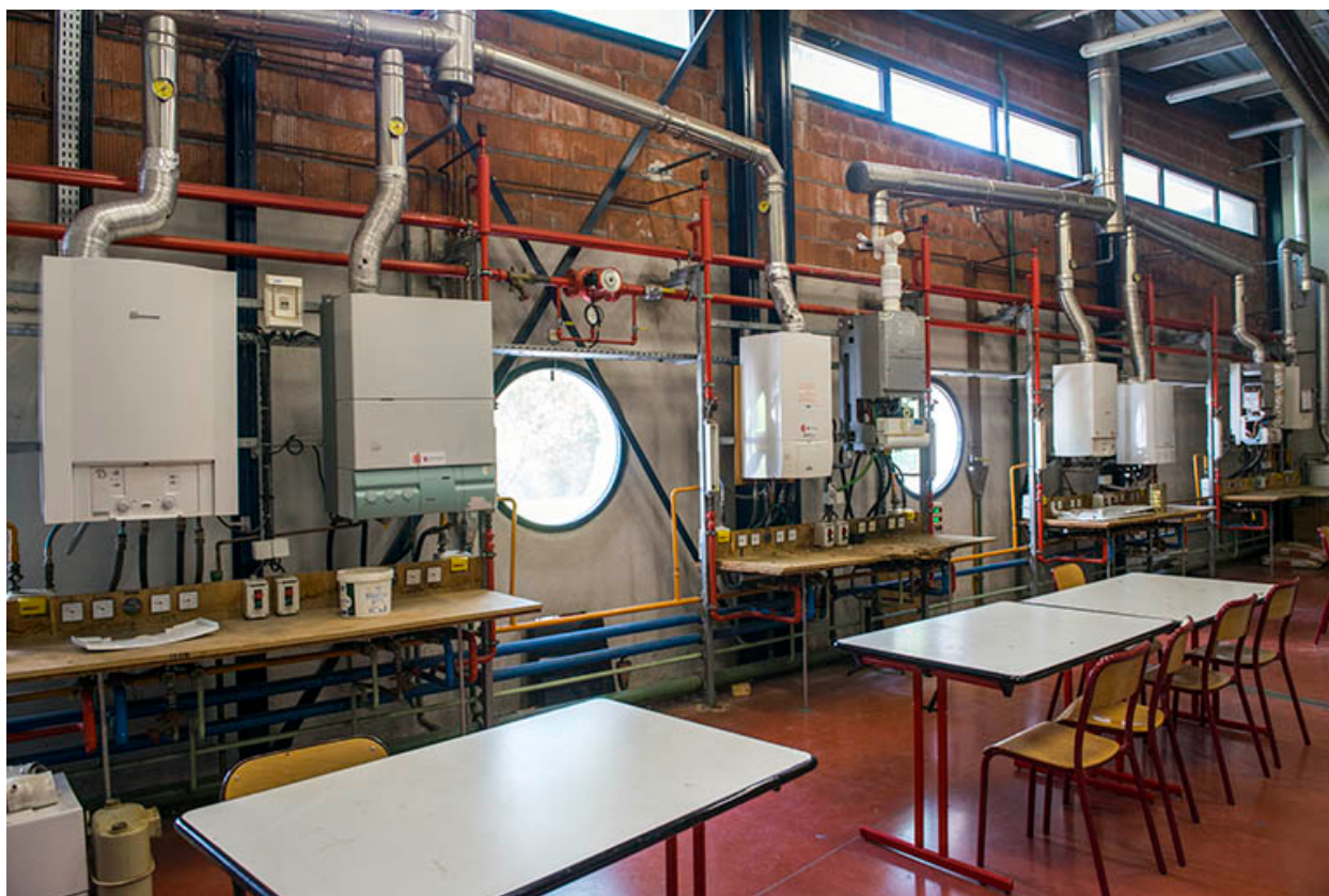
Vue intérieure des ateliers du pôle énergie.
