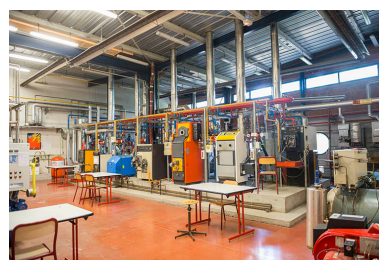
Vue intérieure des ateliers du pôle énergie.
