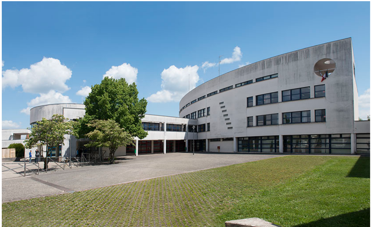
Cour et façade antérieure nord-ouest de l'externat.
