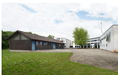
Angle sud-est du chalet et cour postérieure.
