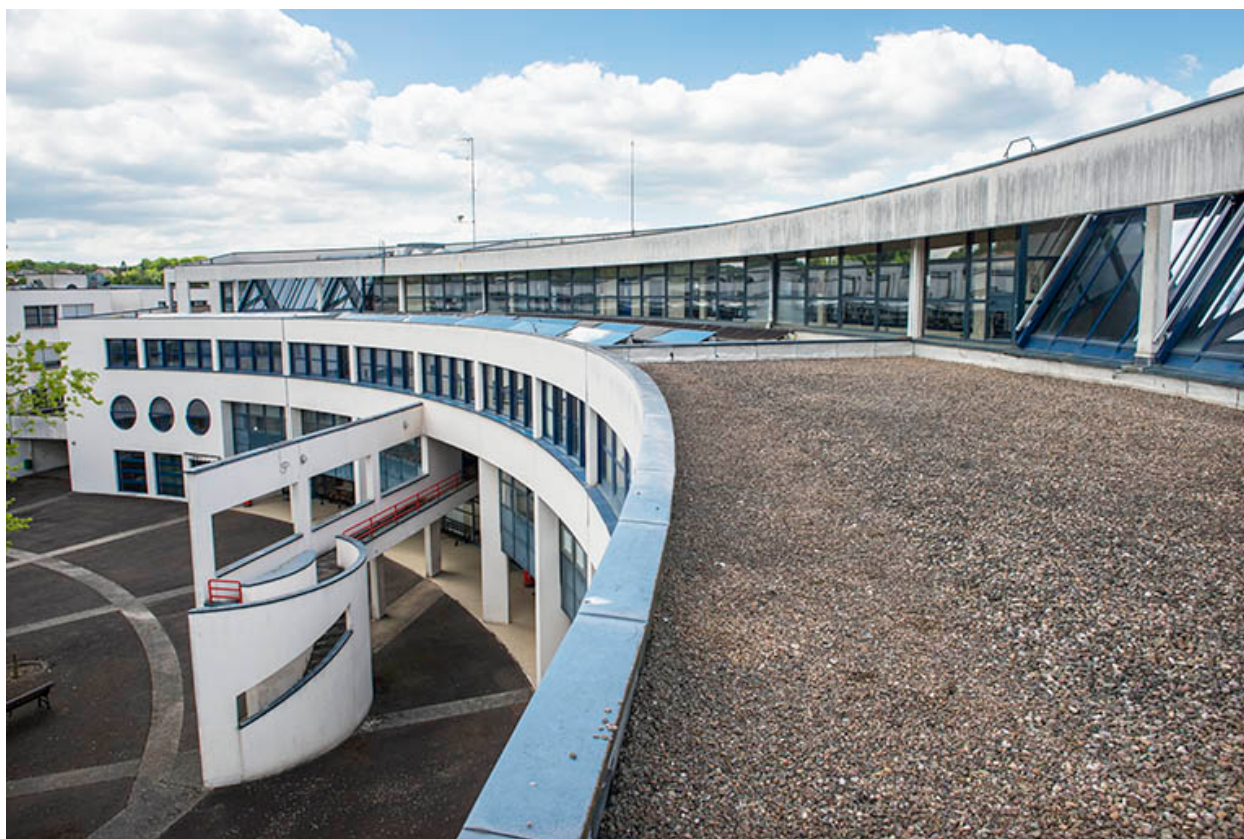
Détail de la terrasse de l'externat semi-circulaire.
