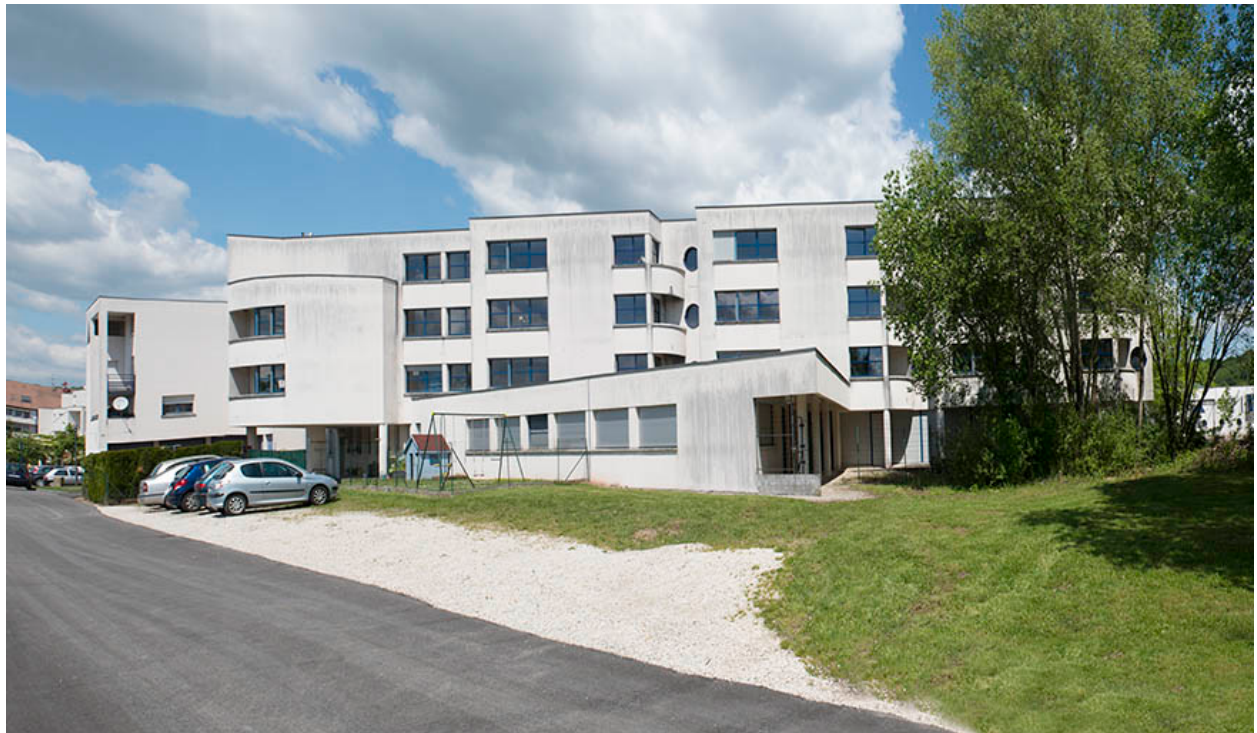
Façades ouest de l'internat.
