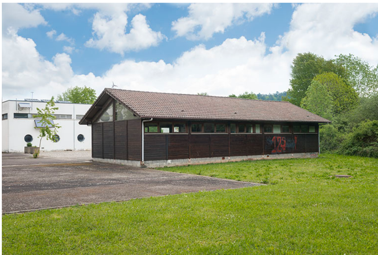
Angle sud-ouest du chalet dans la cour.
