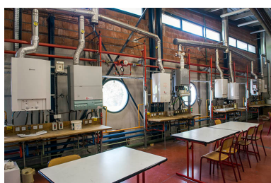
Vue intérieure des ateliers du pôle énergie.
