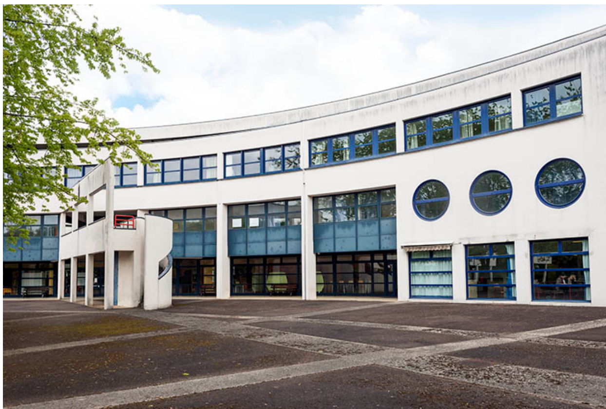
Cour et façade postérieure sud de l'externat.
