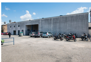
Façade ouest de l'atelier.
