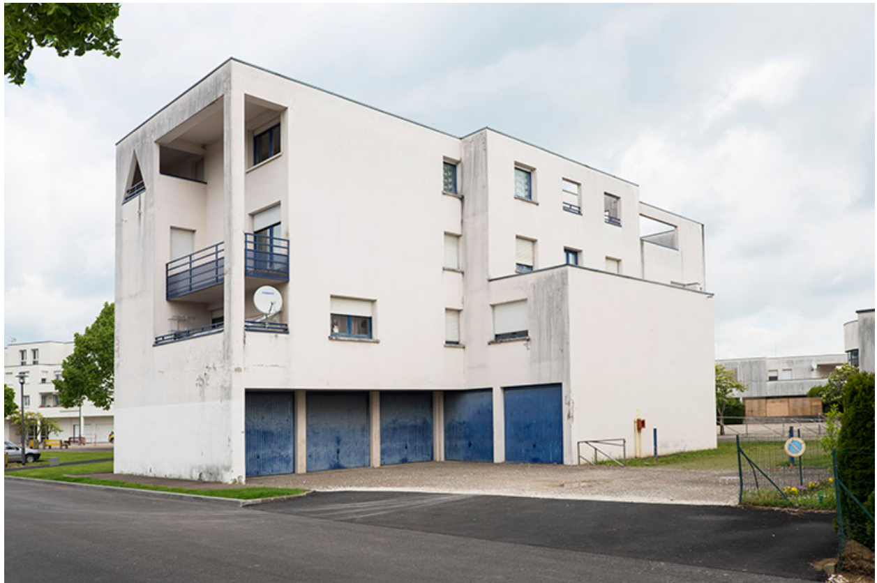
Angle sud-ouest des logements ouest.
