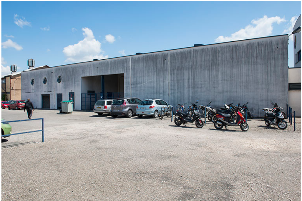
Façade ouest de l'atelier.
