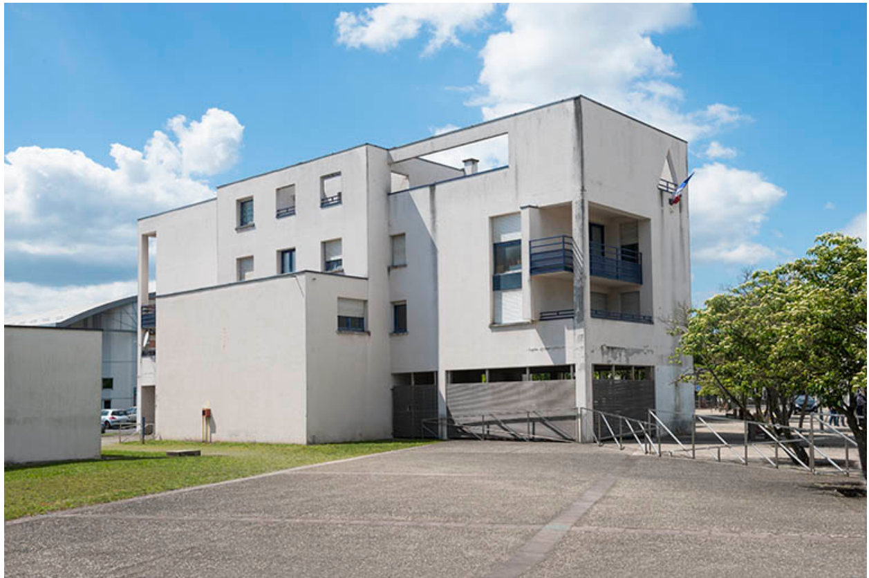
Angle sud-est des logements ouest.
