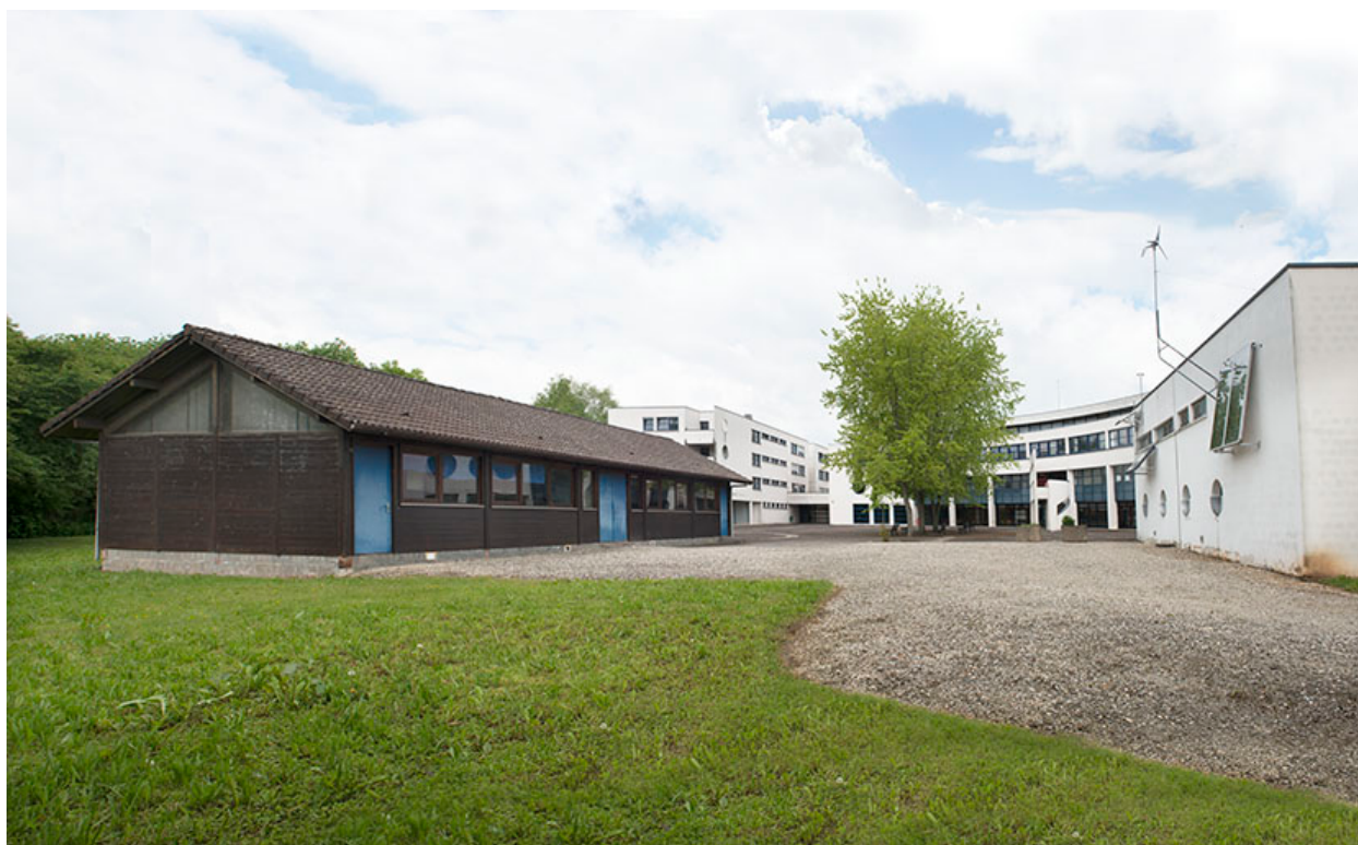
Angle sud-est du chalet et cour postérieure.
