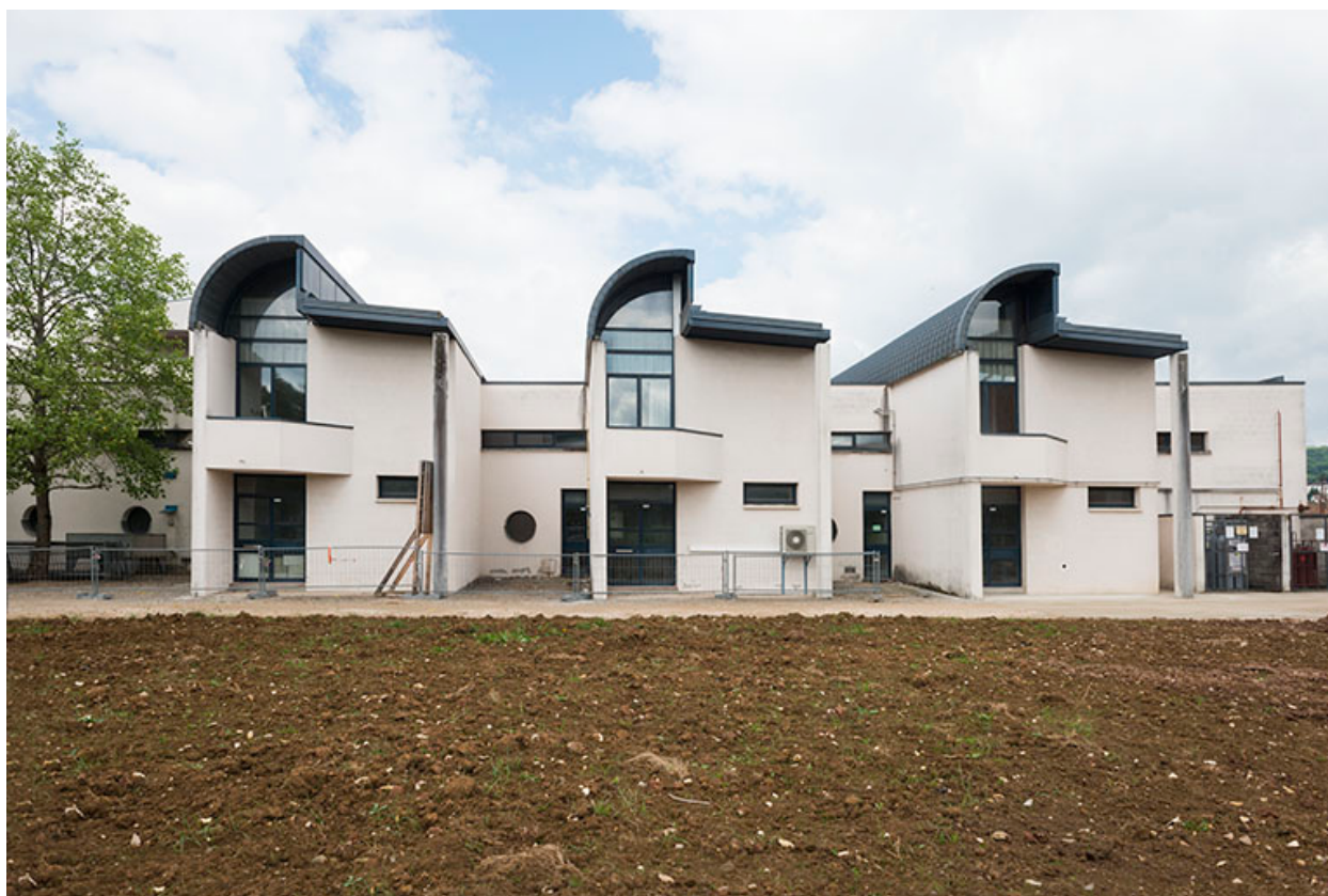
Façades postérieures sud-est des ateliers.
