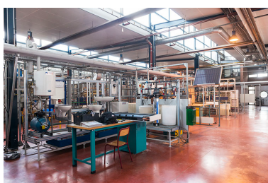
Vue intérieure des ateliers du pôle énergie.
