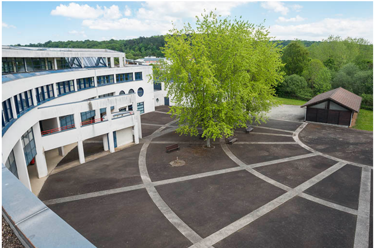
Cour et façade postérieure sud de l'externat.
