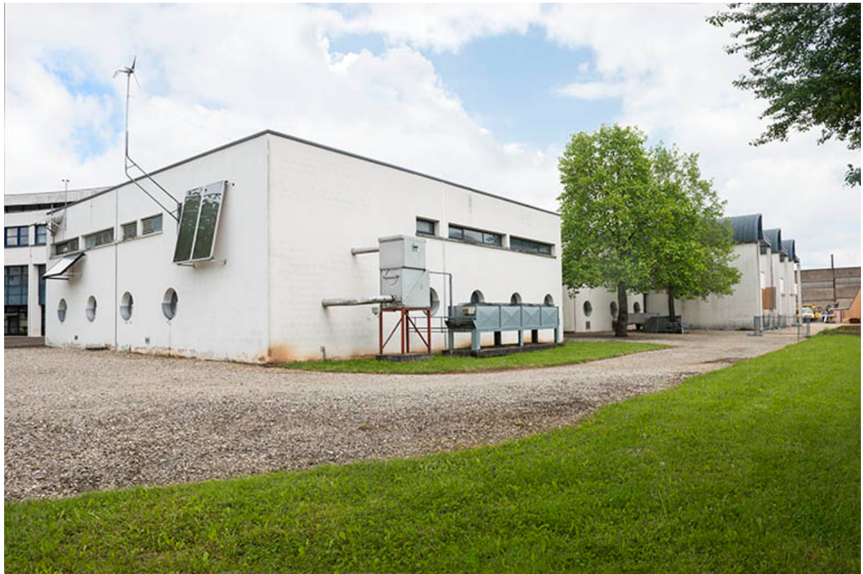
Angle sud de l'extension sud-ouest de l'atelier.
