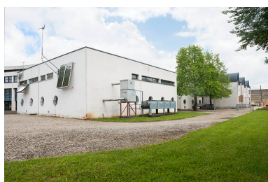
Angle sud de l'extension sud-ouest de l'atelier.
