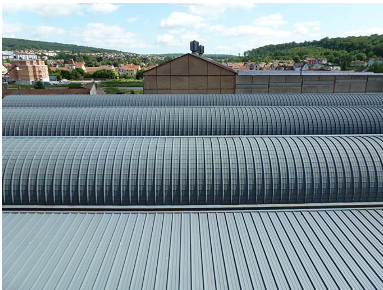
Toiture des ateliers.
