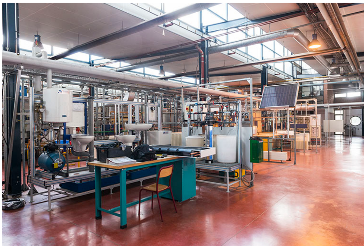
Vue intérieure des ateliers du pôle énergie.
