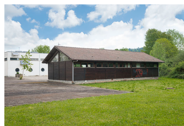
Angle sud-ouest du chalet dans la cour.
