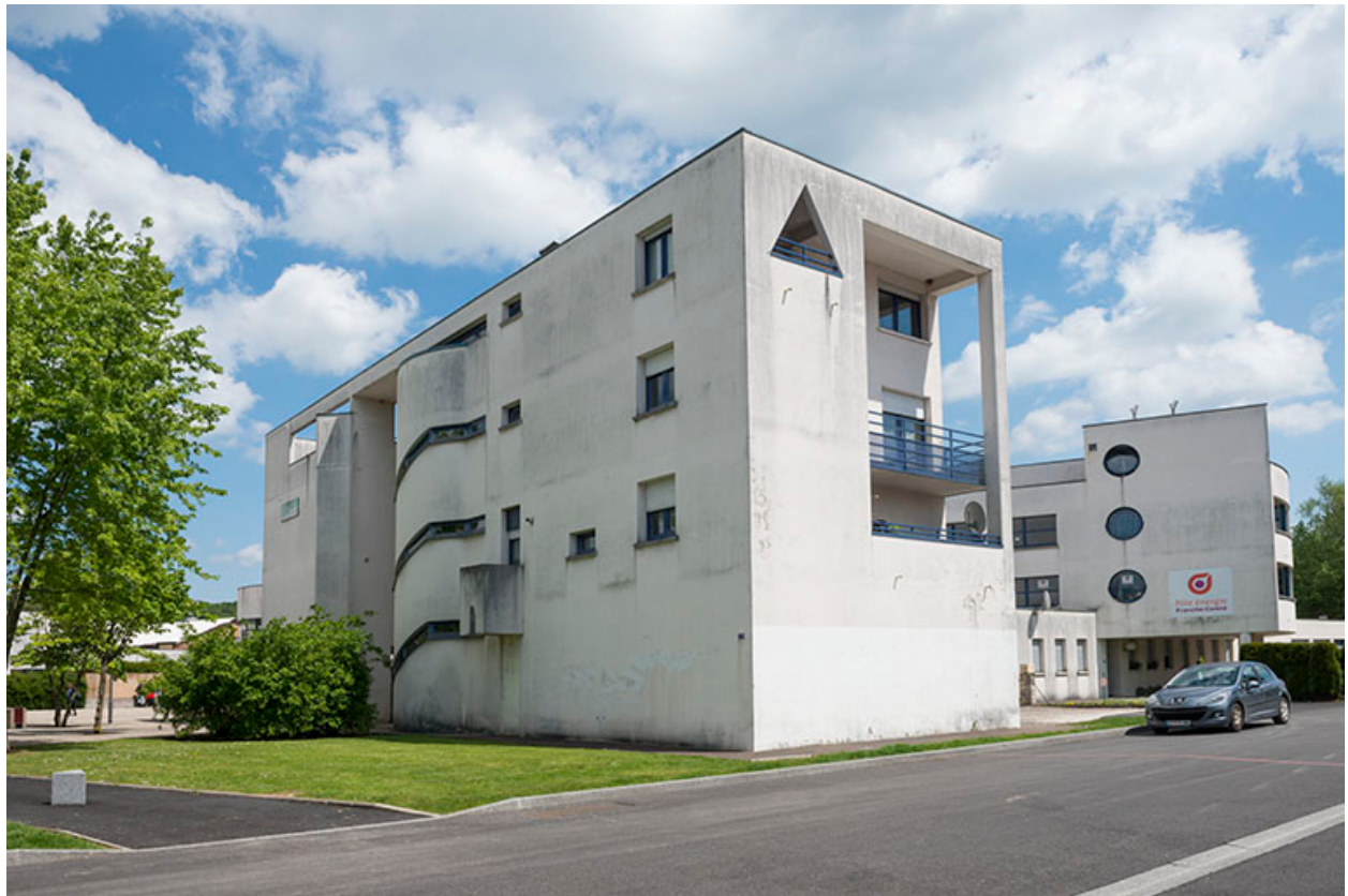
Vue depuis l'angle nord-ouest des logements sud-ouest.
