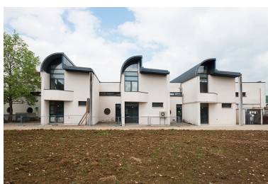
Façades postérieures sud-est des ateliers.
