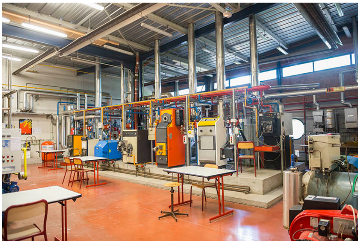
Vue intérieure des ateliers du pôle énergie.
