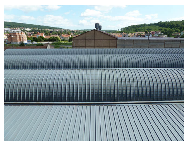
Toiture des ateliers.
