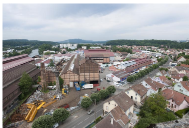
Audincourt, usine des Forges : vue plongeante sur la partie nord. Phot. Jérôme Mongreville IVR43_20122501273NUC4A
