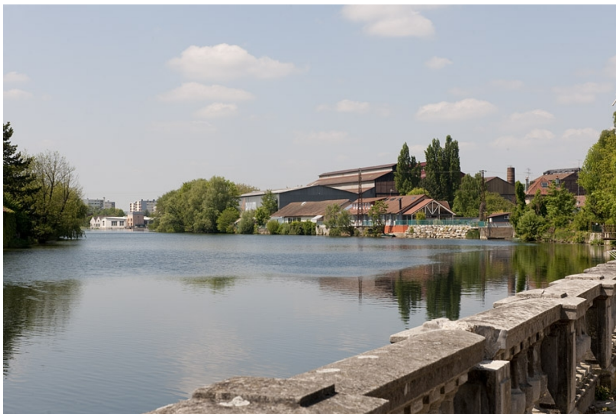
Audincourt, usine des Forges : vue d'ensemble depuis le sud-est.
