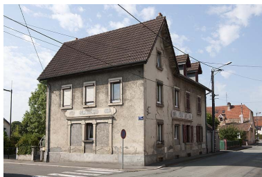
Magasin coopératif de la Fraternelle. Phot. Jérôme Mongreville IVR43_20112502380NUC4A
