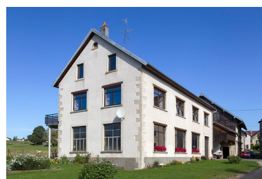
Ancienne fonderie : façades antérieure et latérale gauche.
