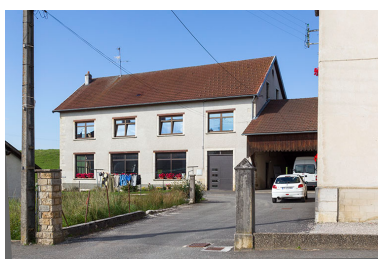
Ancienne fonderie : façade antérieure.
