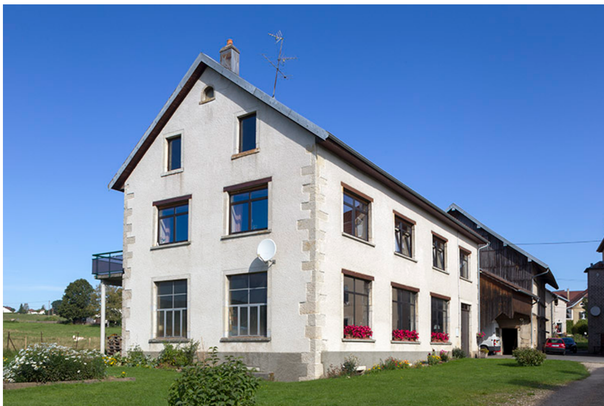
Ancienne fonderie : façades antérieure et latérale gauche.
