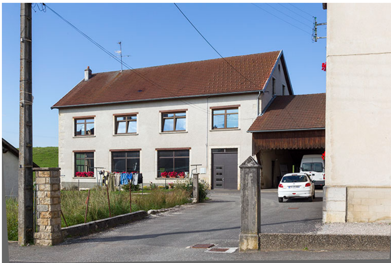
Ancienne fonderie : façade antérieure.
