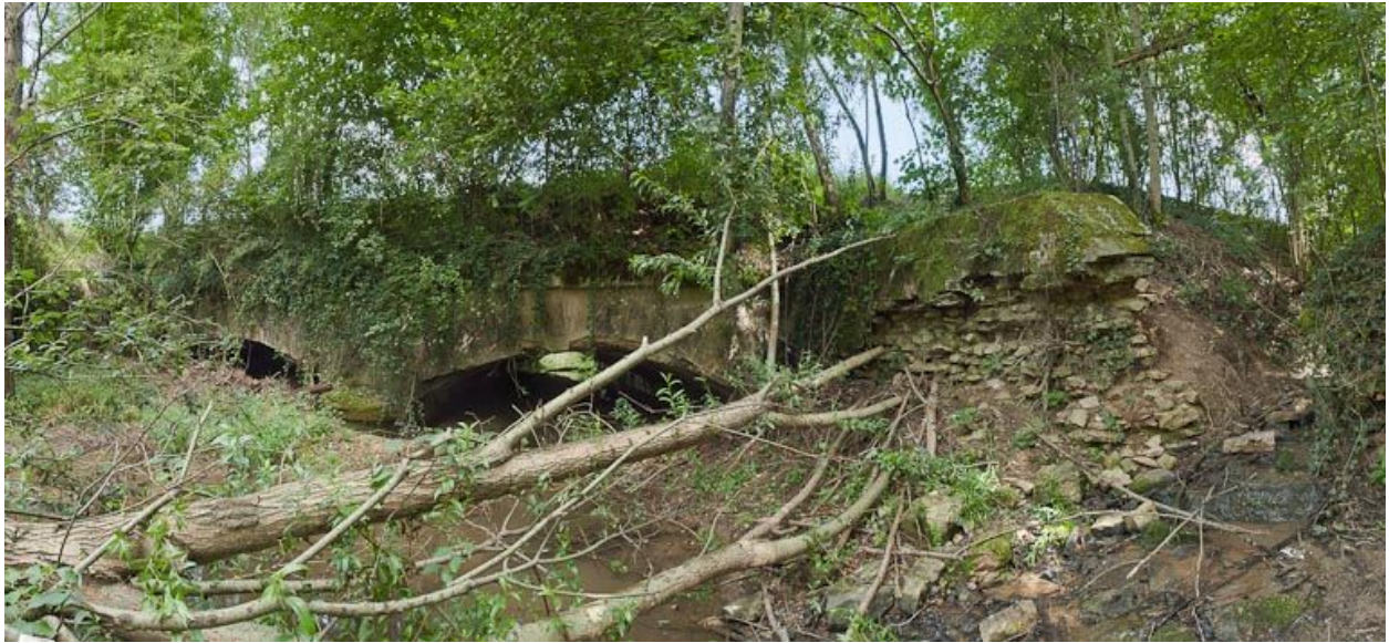
Vue des deux arches de l'aqueduc.
