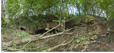
Vue des deux arches de l'aqueduc. Phot. Pierre-Marie Barbe-Richaud IVR26_20112104047NUC4AQ
