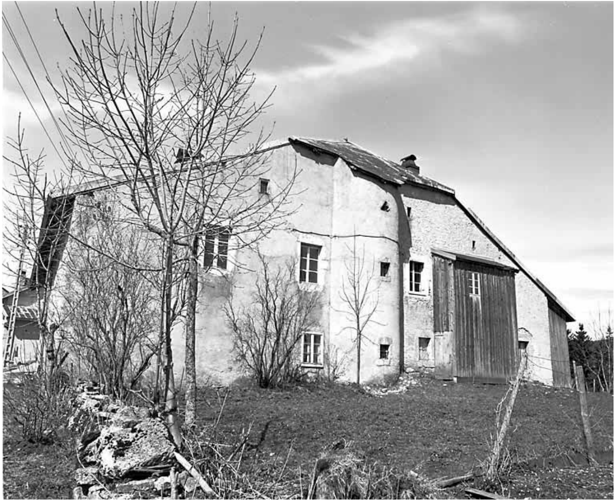
Façade latérale droite.
