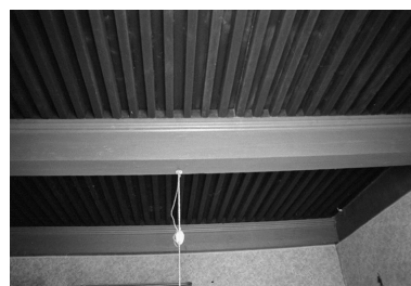
Intérieur : plafond de la cuisine. Phot. Gilbert Poinot IVR43_19752500993Z
