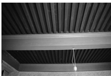
Intérieur : plafond de la cuisine. Phot. Gilbert Poinot IVR43_19752500990Z
