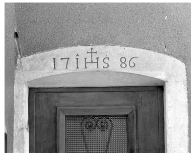
Linteau de la porte du rez-de-chaussée. Phot. Jérôme Mongreville IVR43_19943901160X
