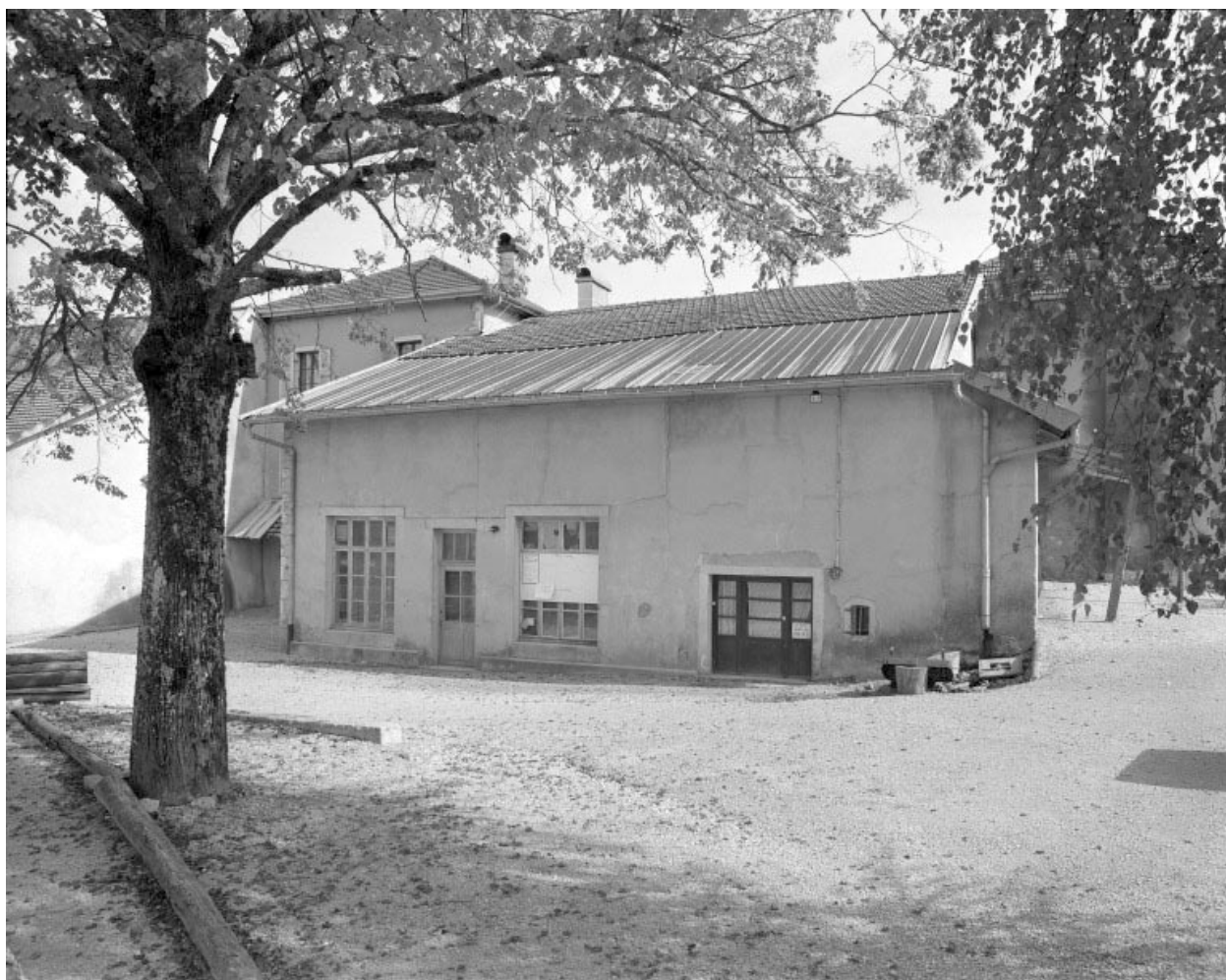
Façade postérieure du corps central.
