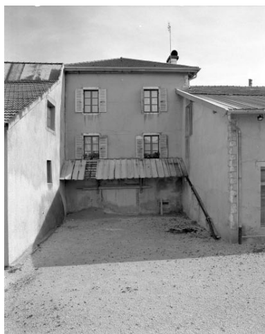
Façade postérieure du corps latéral. Phot. Jérôme Mongreville IVR43_19943901125X
