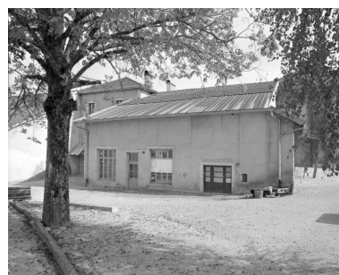
Façade postérieure du corps central. Phot. Jérôme Mongreville IVR43_19943901124X
