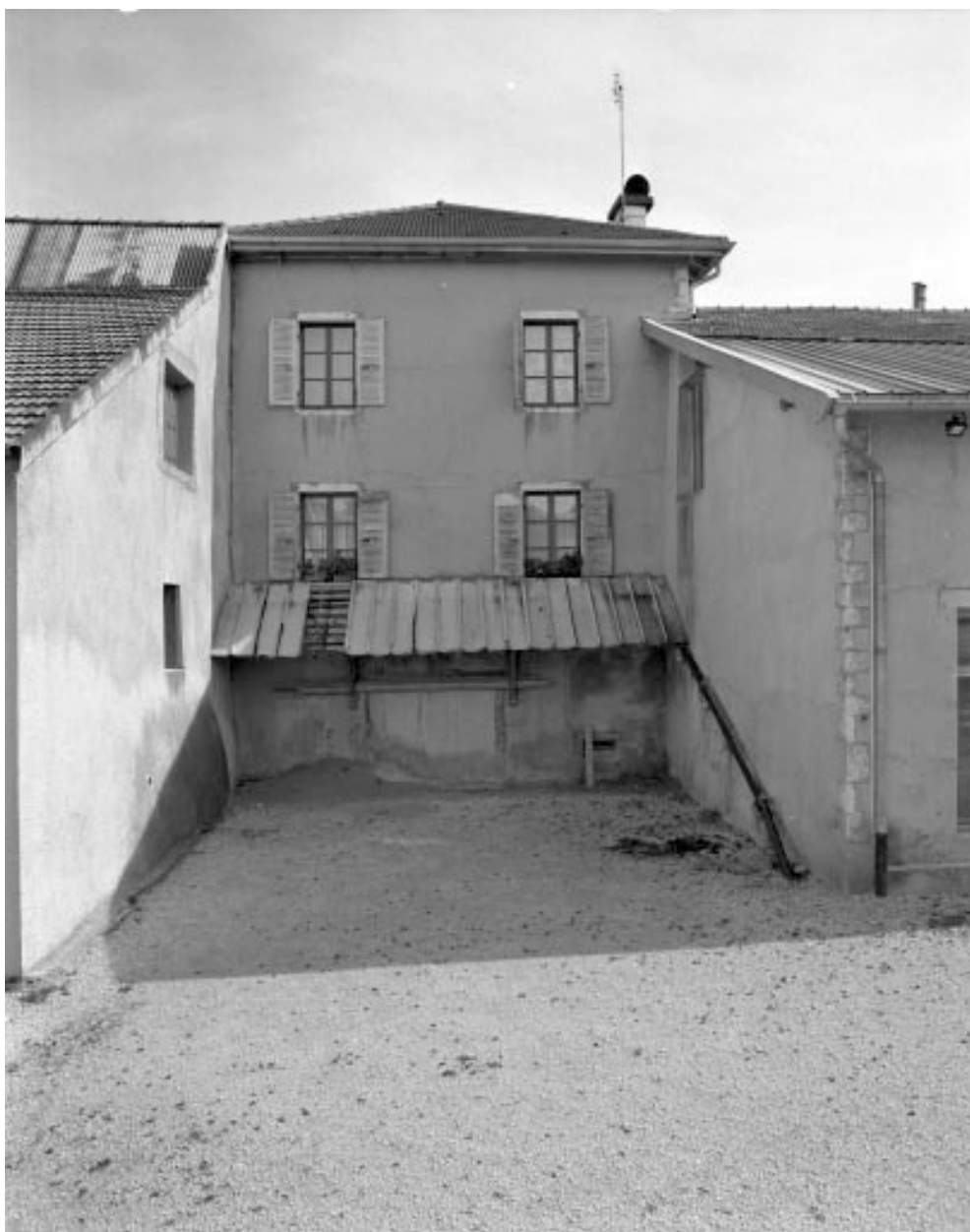
Façade postérieure du corps latéral.
