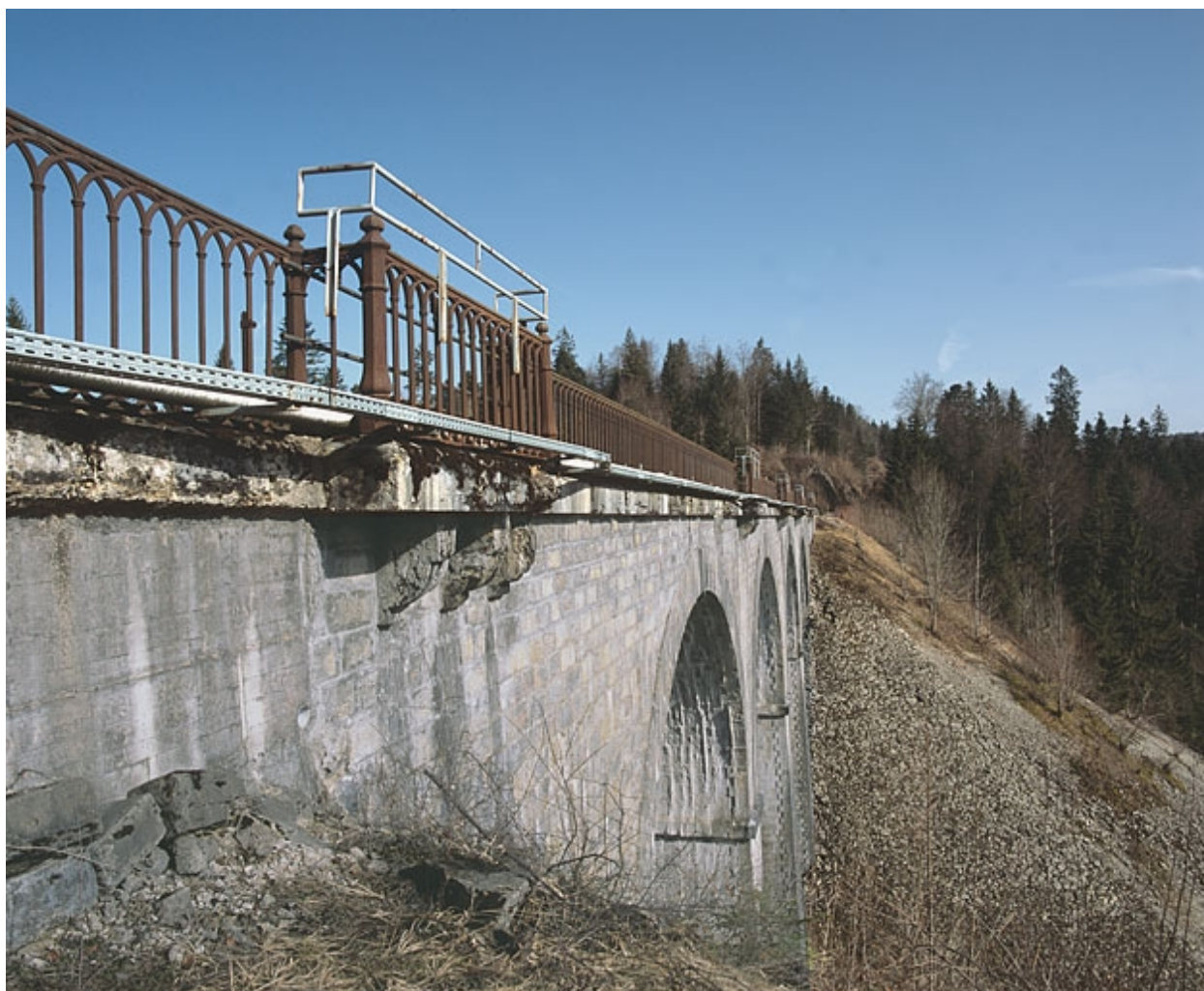
Garde-corps de l'élévation orientale.
