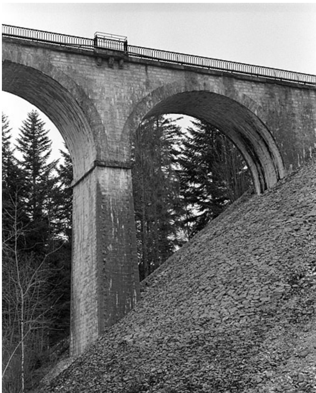
Première arche côté Andelot-en-Montagne, depuis l'est.
