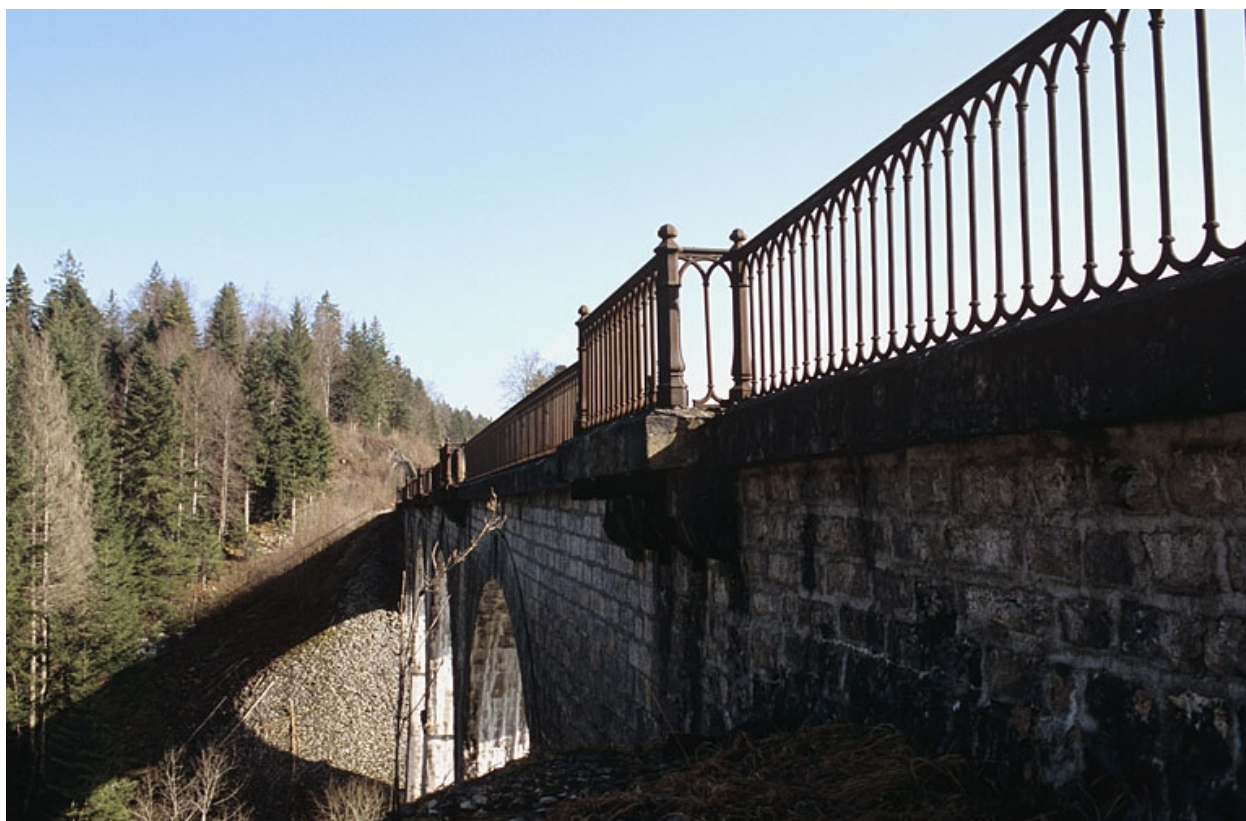
Garde-corps de l'élévation occidentale.
