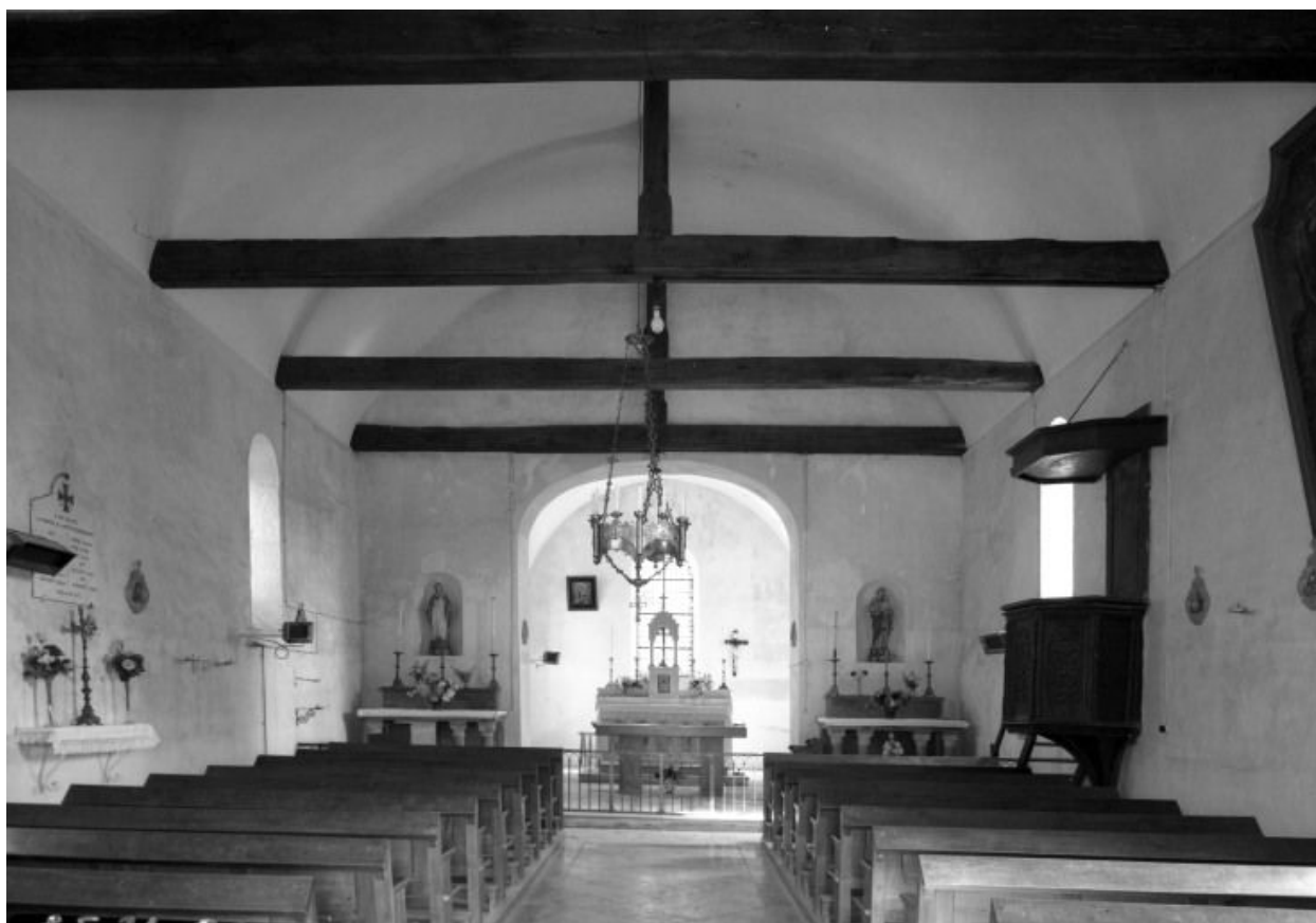
Vue intérieure prise depuis l'entrée
