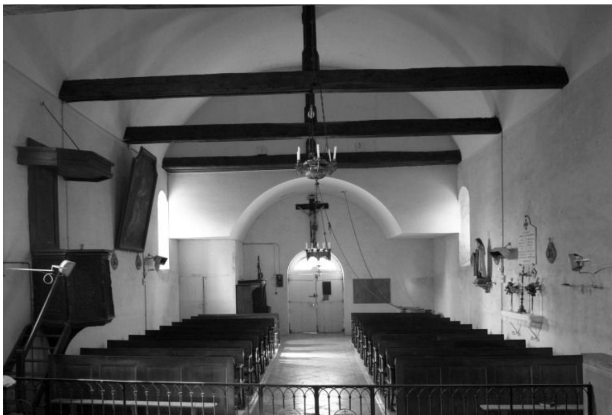
Vue intérieure prise depuis le chœur
