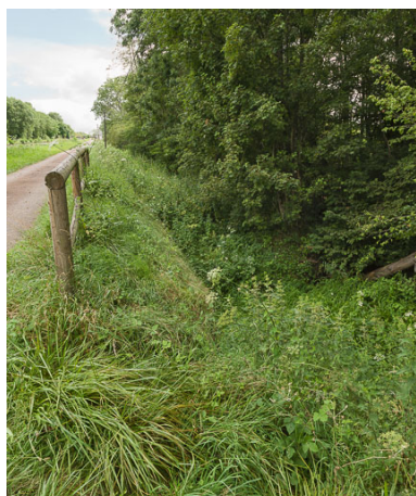
Vue de l'aqueduc.
