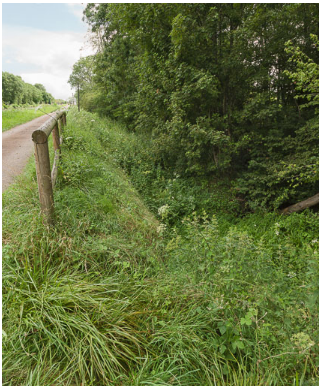
Vue de l'aqueduc.
