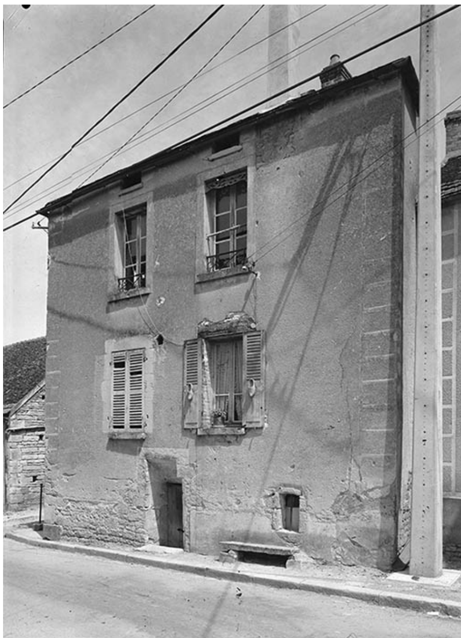
Façade antérieure sur rue.
