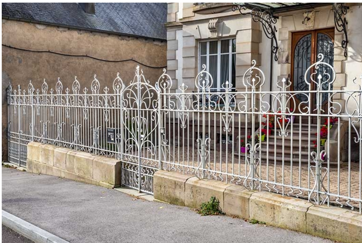
Grille de clôture.
