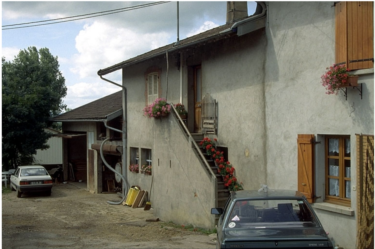
Façade antérieure vue de trois quarts droite.
