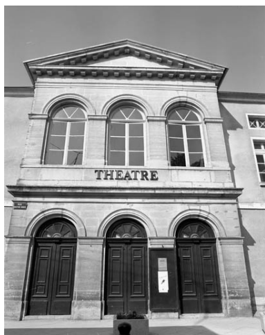
Façade antérieure : détail de l'avant-corps central. Phot. Yves Sancey IVR43_19917000390X
