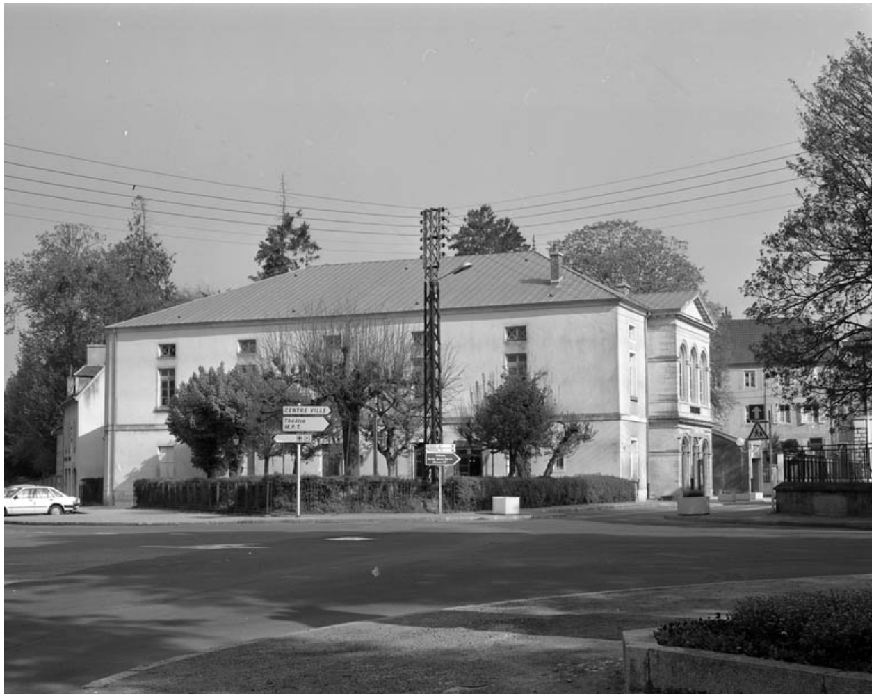
Façades antérieure et latérale gauche.
