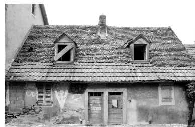
Elevation antérieure, rue de la Poste.
