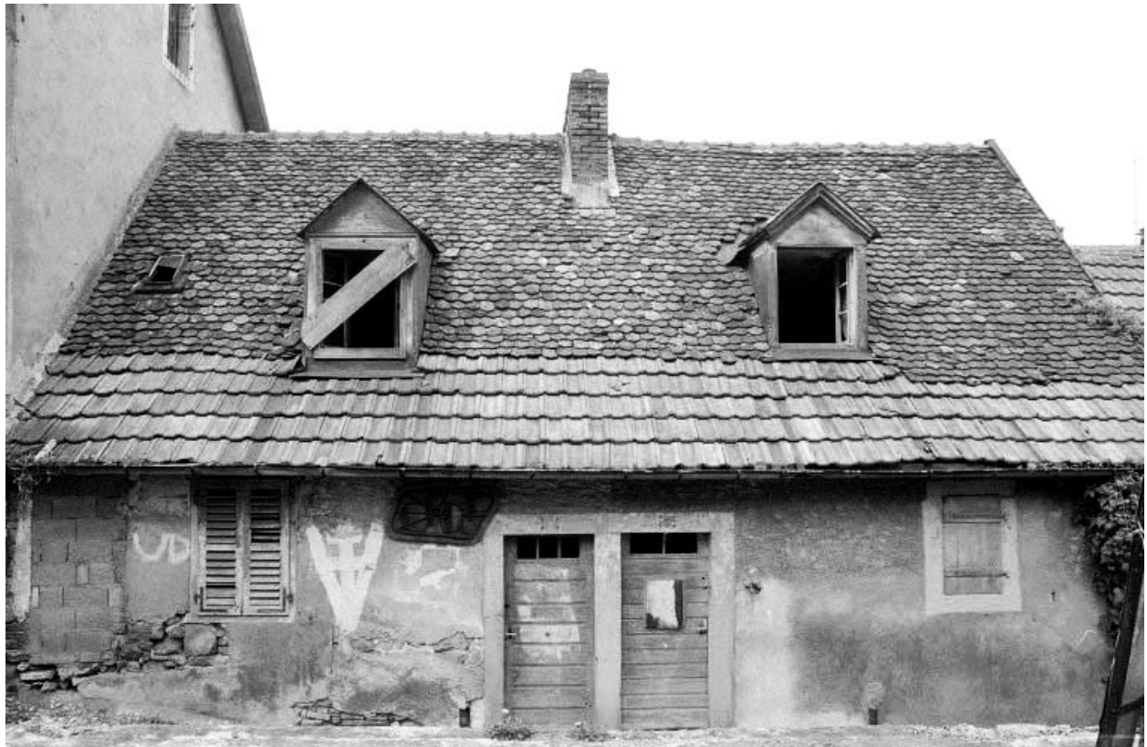
Elevation antérieure, rue de la Poste.
