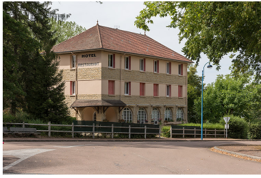
Élévation sur l'avenue du Docteur Segard. Phot. Pierre-Marie Barbe-Richaud IVR26_20195800685NUC4A
