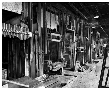
Usine de taille de matériaux de construction Célard, à Saint-Amour : vue d'ensemble des sept châssis de scie multilames.
