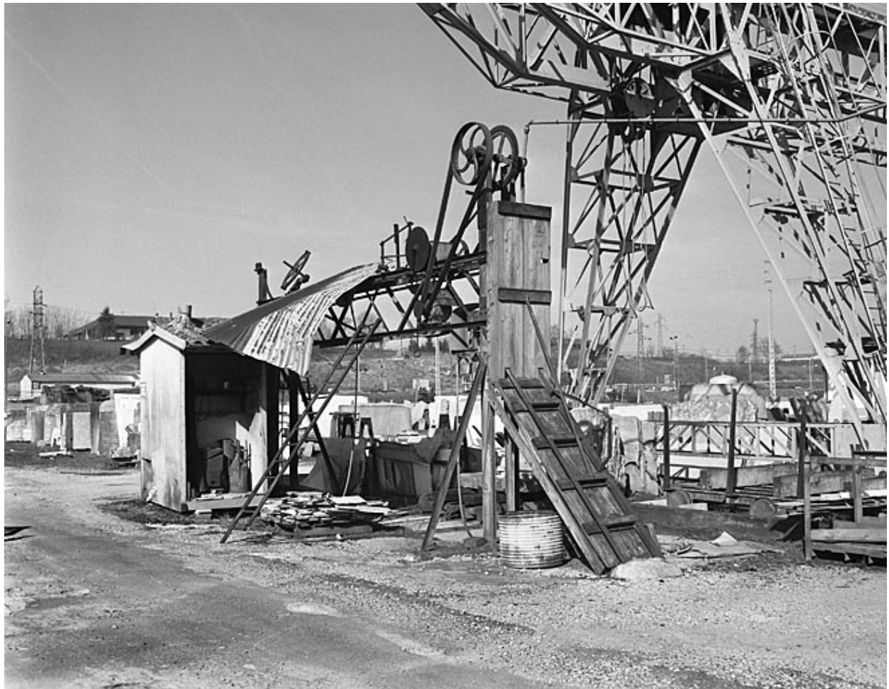
Usine de taille de matériaux de construction Célard, à Saint-Amour : scie à fil hélicoïdal.
