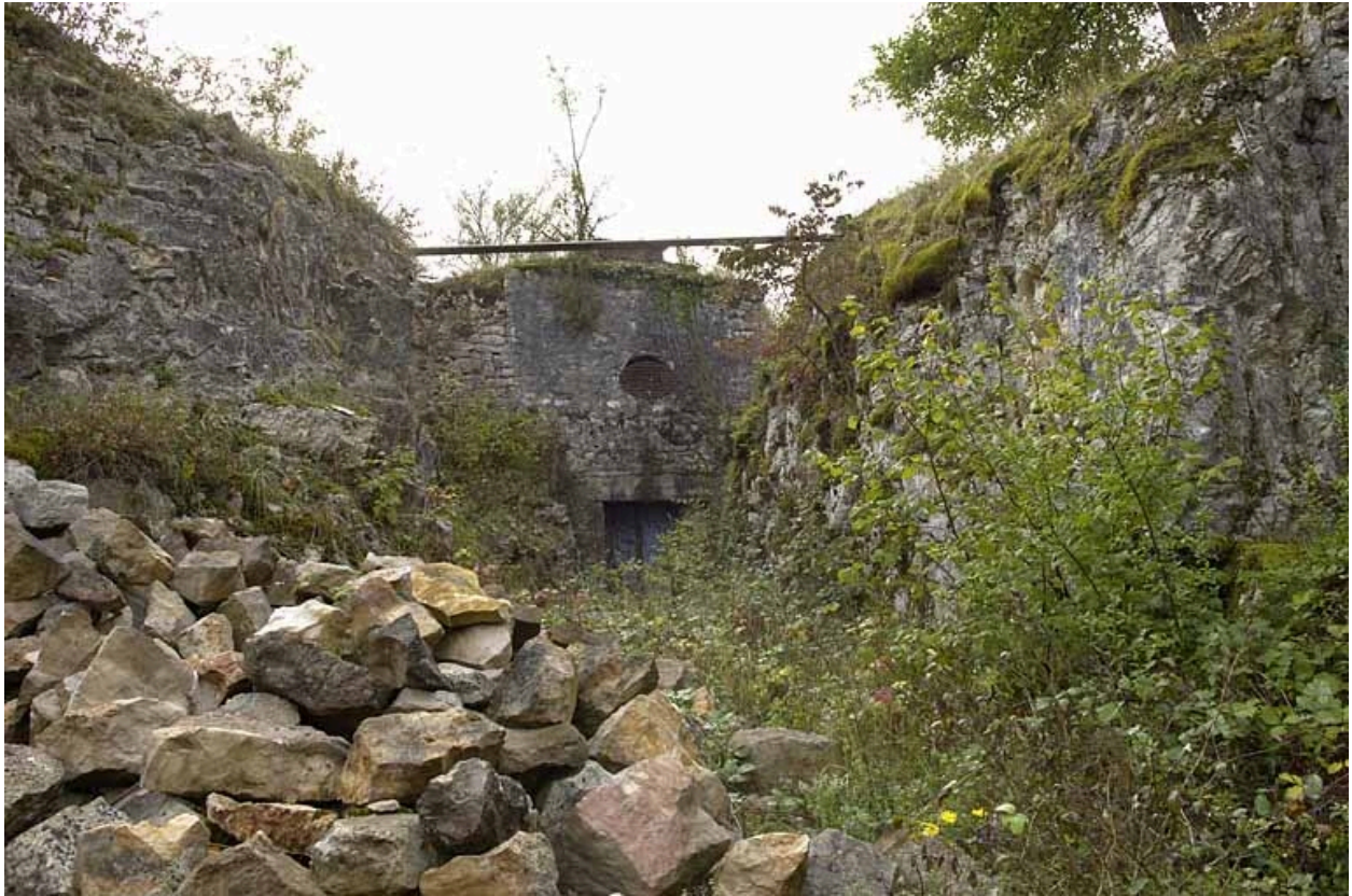
Carrière des Fourneaux, à Sampans : bâtiment (poudrière ?).
