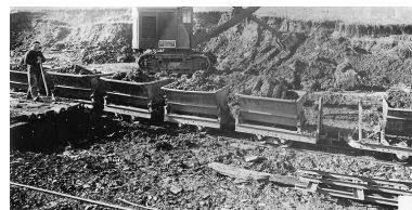
Chargement des wagonnets à la carrière. Phot. Emile Hérissé, Phot. Emile Hérissé IVR43_20077000469NUCA
