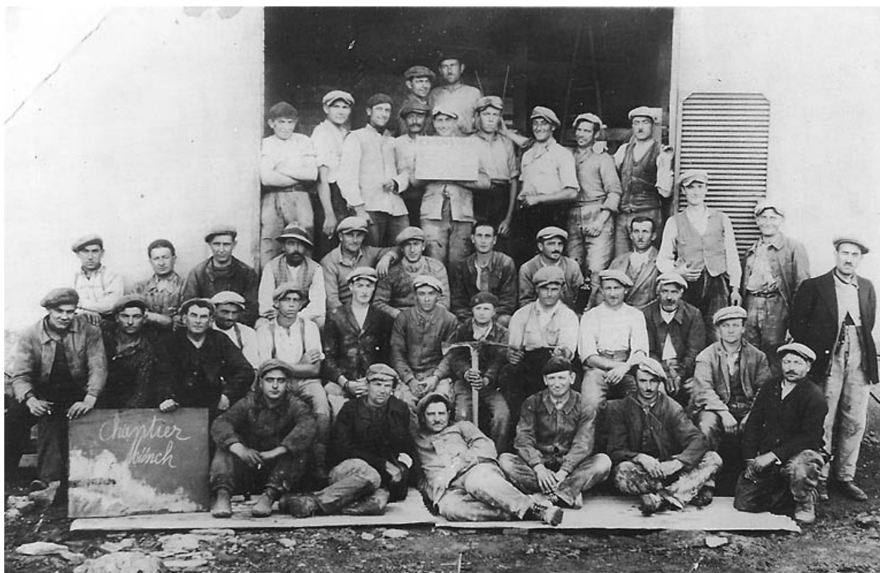
Ouvriers de l'entreprise Cilia [ ?] chantier Münch.
