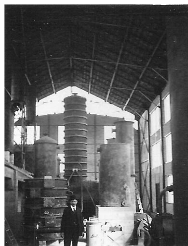
Vue intérieure de la raffinerie. Phot. Emile Hérissé, Phot. Emile Hérissé IVR43_20077000478NUCA
