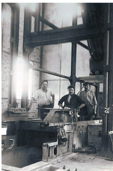
Bâtiment des fours. Montage des grilles automatiques. Phot. Emile Hérissé, Phot. Emile Hérissé IVR43_20077000462NUCA
