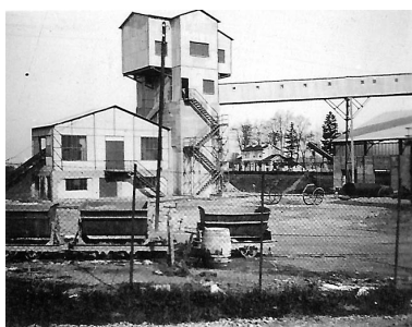
L'ensemble de concassage depuis l'est. Phot. Emile Hérissé, Phot. Emile Hérissé IVR43_20077000471NUCA
