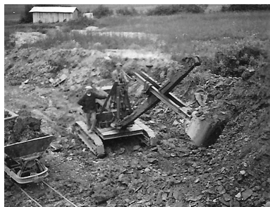
La pelle mécanique. Chargement d'un wagonnet. Phot. Emile Hérissé, Phot. Emile Hérissé IVR43_20077000481NUCA
