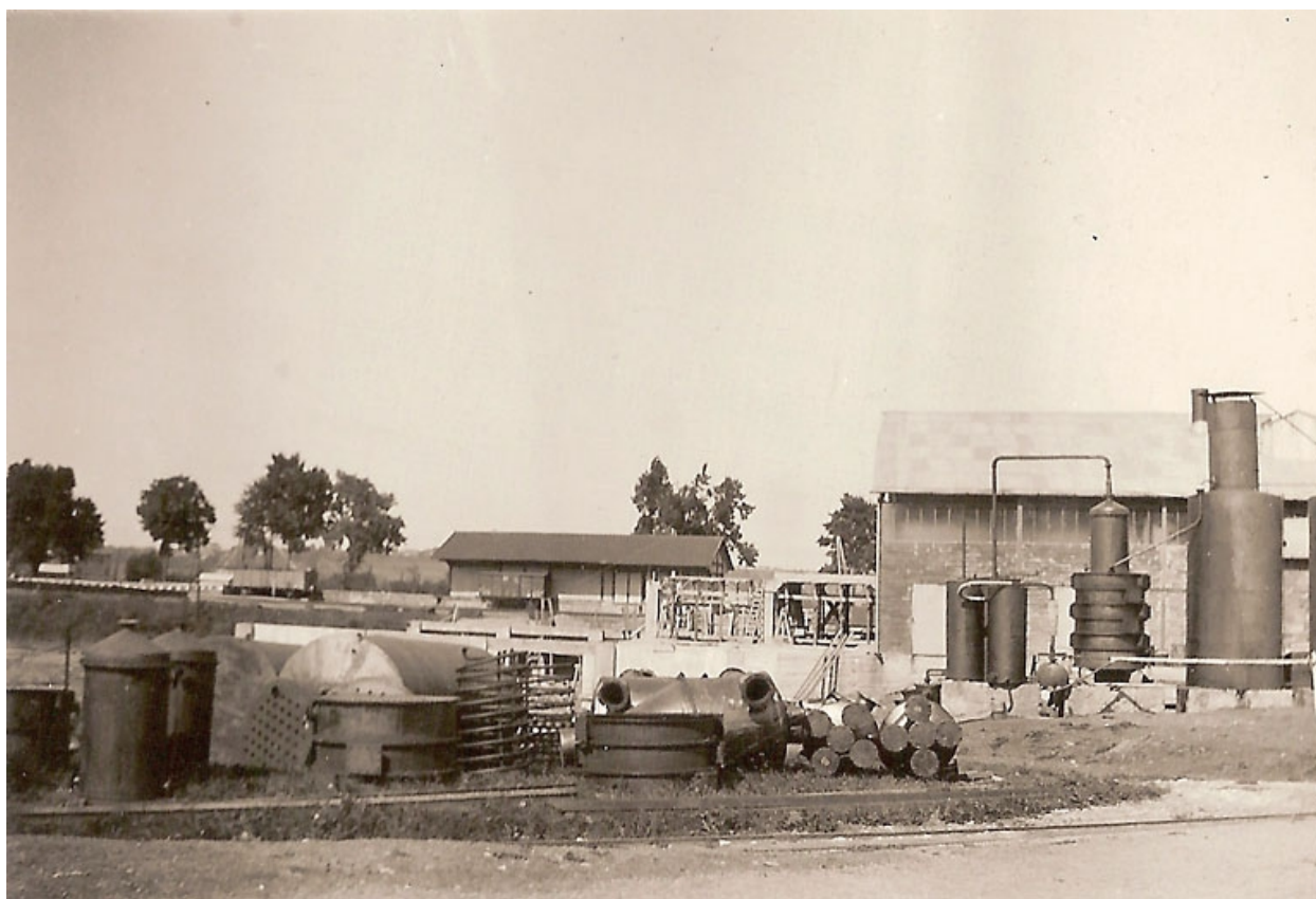
Agrandissement du bâtiment des fours.
