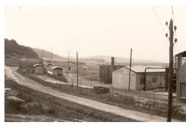
Bureaux et ateliers. Phot. Emile Hérissé, Phot. Emile Hérissé IVR43_20077000451NUCA
