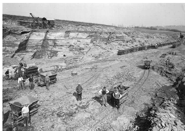
Vue d'ensemble de la carrière en exploitation. Phot. Emile Hérissé, Phot. Emile Hérissé IVR43_20077000468NUCA
