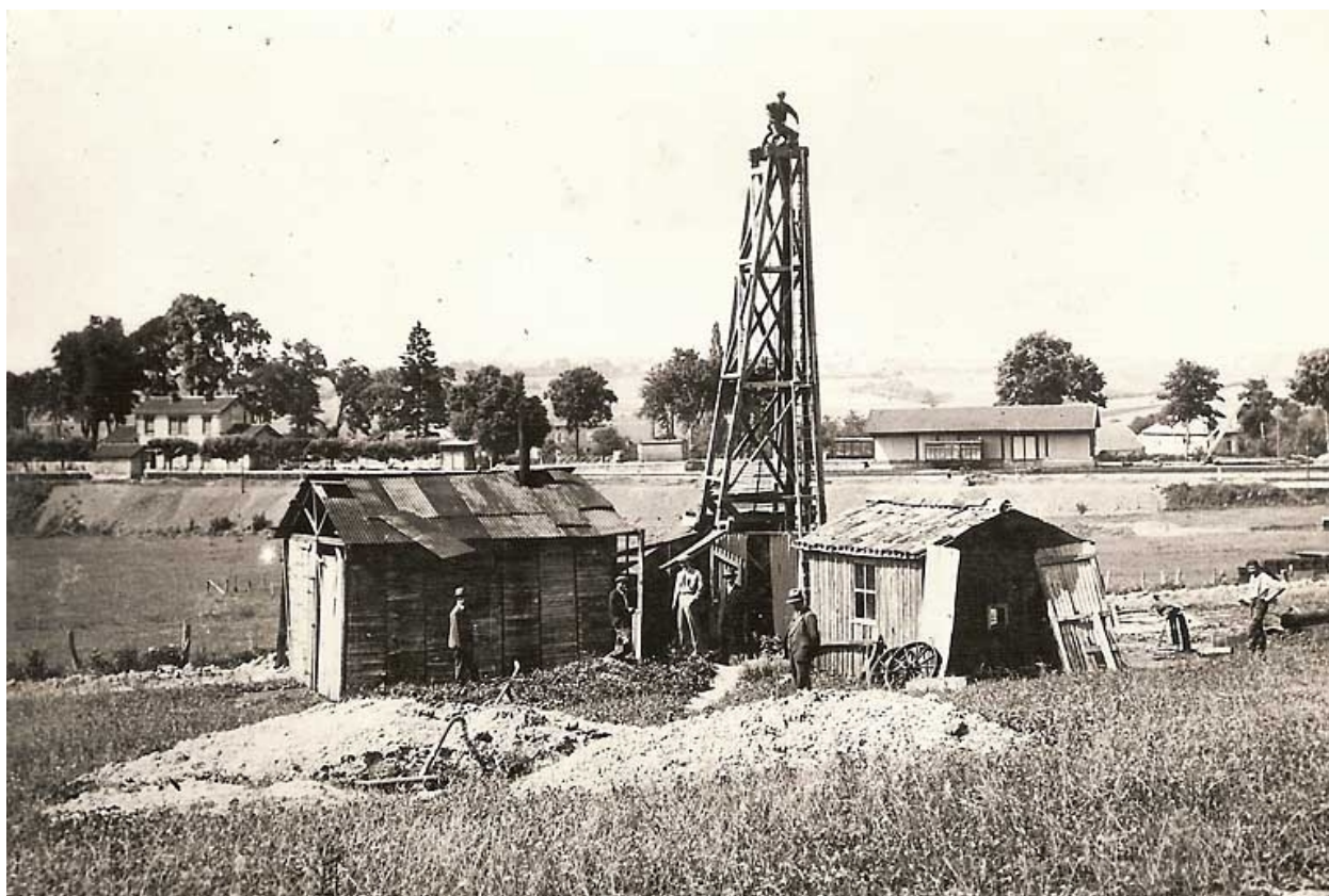
Forage du puits d'eau potable.
