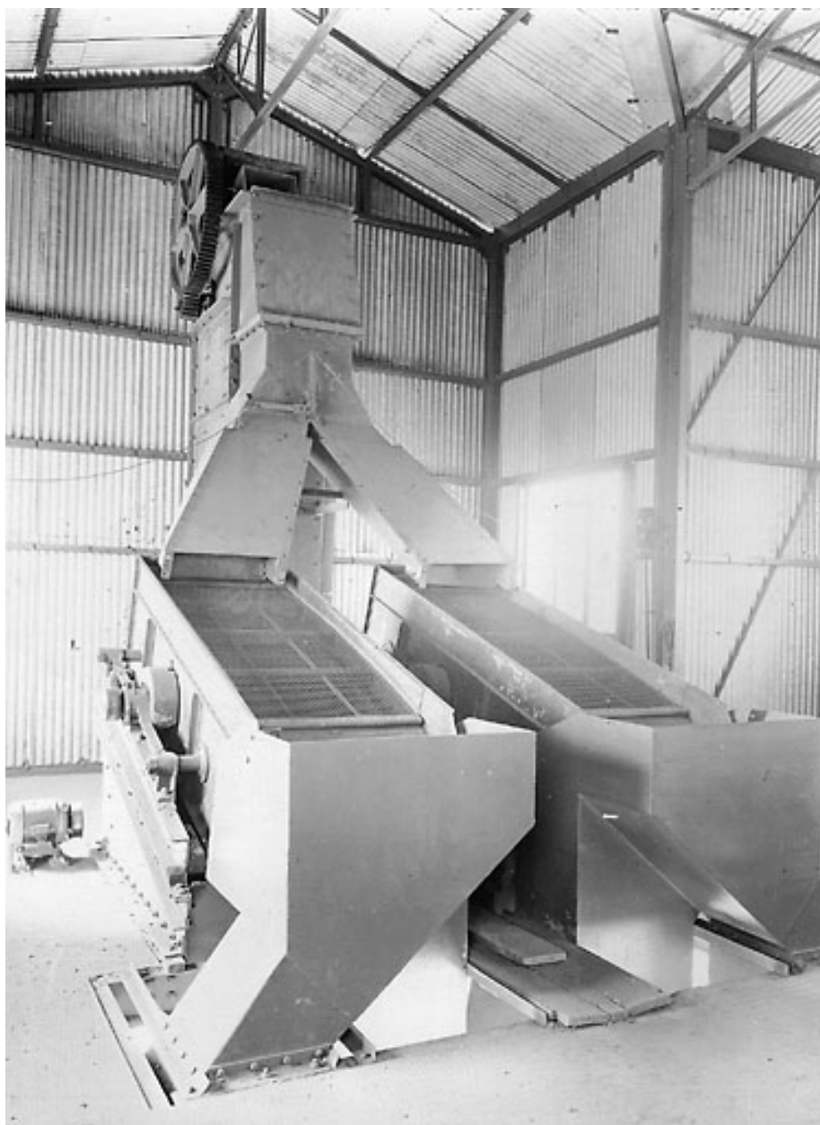
Atelier de concassage. Cribles vibrants.
