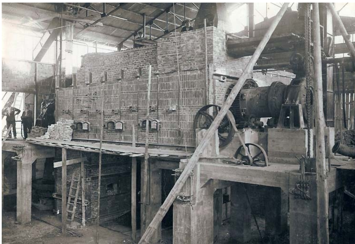
Bâtiment des fours. Four d'essai des schistes.
