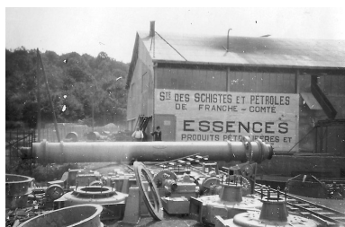
Déchargement du four. Phot. Emile Hérissé, Phot. Emile Hérissé IVR43_20077000487NUCA
