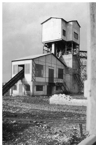
L'ensemble de concassage vu de trois quarts. Phot. Emile Hérissé, Phot. Emile Hérissé IVR43_20077000483NUCA
