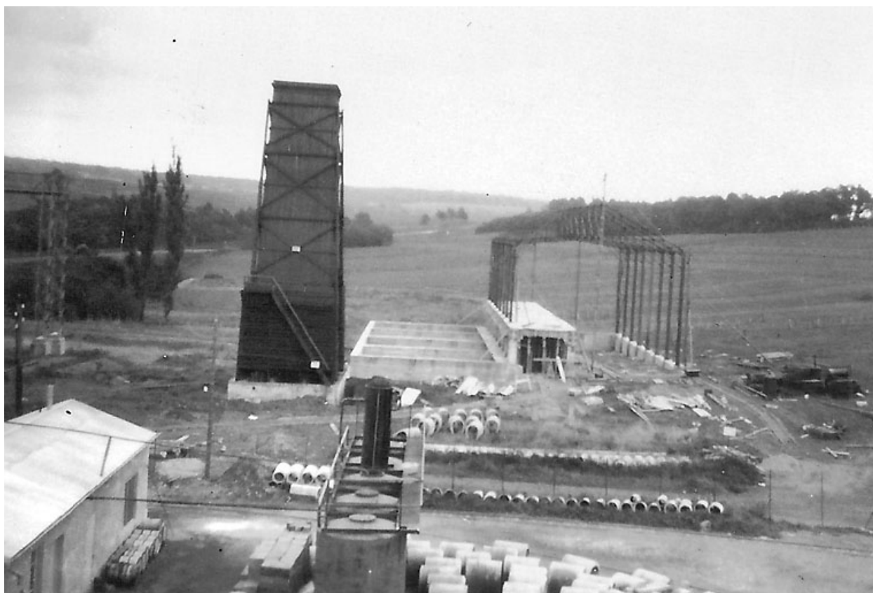
Tour de réfrigération et raffinerie en construction.
