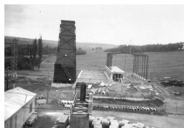
Tour de réfrigération et raffinerie en construction. Phot. Emile Hérissé, Phot. Emile Hérissé IVR43_20077000472NUCA
