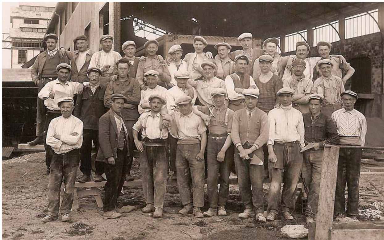
Ouvriers de l'entreprise Cilia [ ?].
