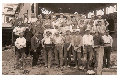
Ouvriers de l'entreprise Cilia [ ?]. Phot. Emile Hérissé, Phot. Emile Hérissé IVR43_20077000455NUCA
