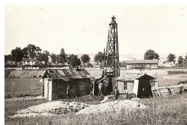
Forage du puits d'eau potable. Phot. Emile Hérissé, Phot. Emile Hérissé IVR43_20077000449NUCA
