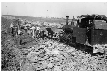
Ouvriers de la carrière et locotracteur. Autr. Emile Hérissé IVR43_20077000466NUCA
