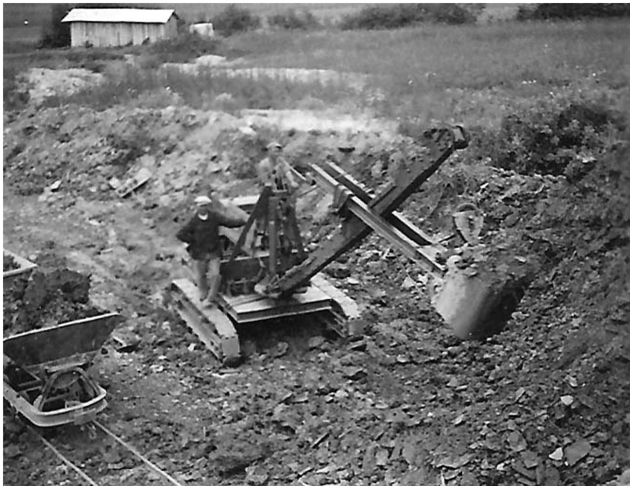
La pelle mécanique. Chargement d'un wagonnet.
