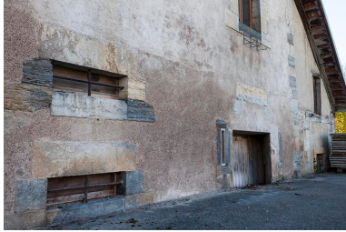
Ouvertures (caves d'affinage) sur la façade postérieure. Phot. Jérôme Mongreville IVR43_20152502374NUC4A
