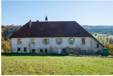
Façade postérieure. Phot. Jérôme Mongreville IVR43_20152502375NUC4A
