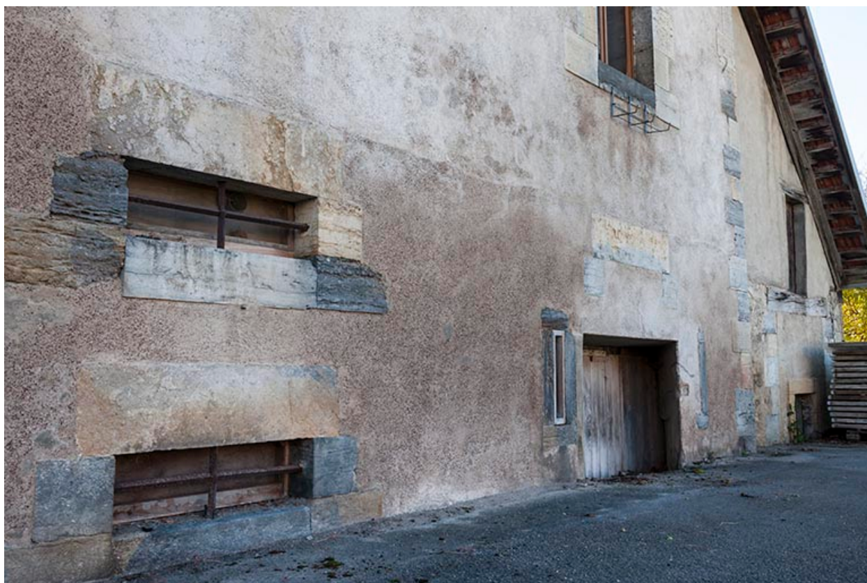
Ouvertures (caves d'affinage) sur la façade postérieure.
