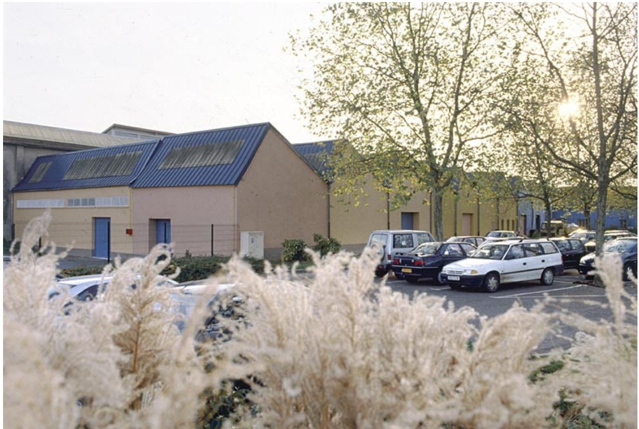
Murs-pignons nord de l'atelier de filature.
