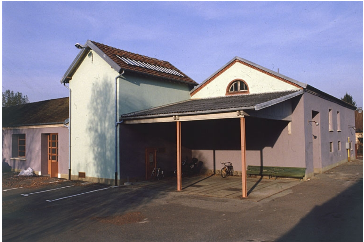
Chaufferie et atelier de forge.
