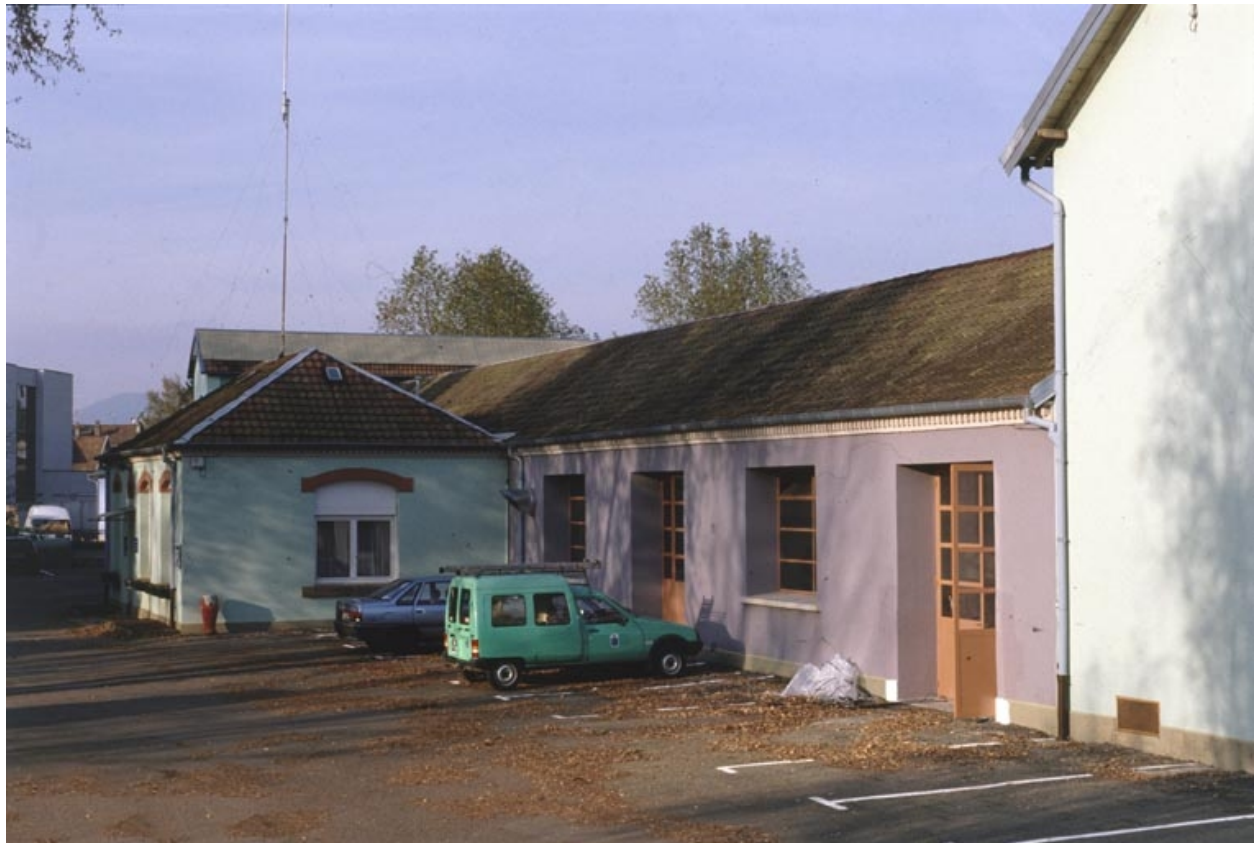
Bureaux et façade de l'atelier du tissage.
