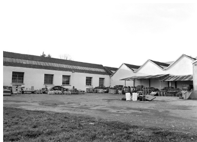
Façades arrière depuis la cour. Phot. Jérôme Mongreville IVR43_20019000612X
