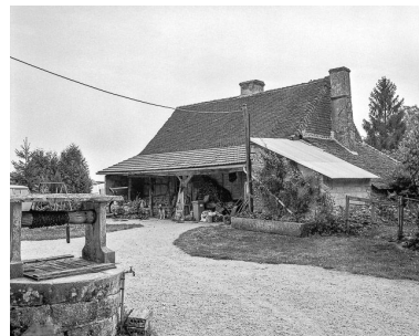
Le bâtiment à gauche de la cour. Phot. Yves Sancey IVR43_19843900025X
