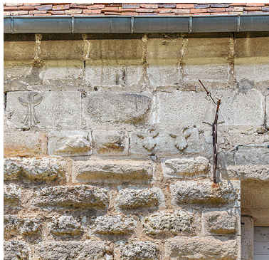
La maçonnerie en bossage de la porte. Phot. Thierry Kuntz IVR26_20232100267NUC4A
